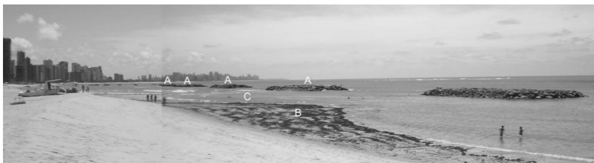
Figura 4.5 - Configuração do quebra-mar em uma maré baixa de sizígia (31 de março de 2014) (A) três das seções restantes quebra-mar, (B) uma saliência (C) uma baía formada pelo sedimento rearranjado pelas ondas e correntes, apenas alguns meses depois da reconfiguração do quebra-mar.
