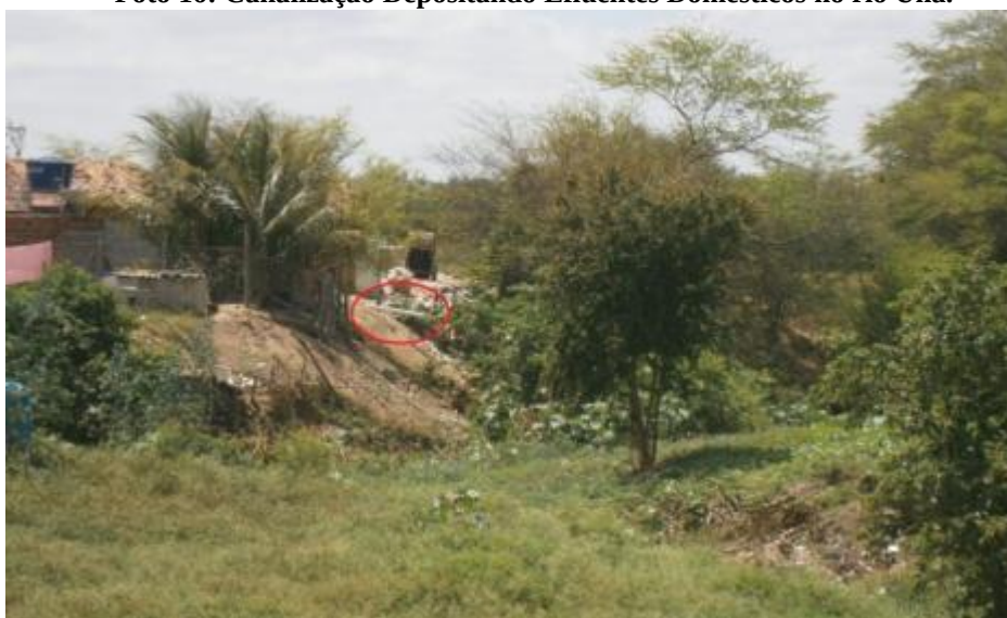
Foto 16: Canalização Depositando Efluentes Domésticos no rio Una.
