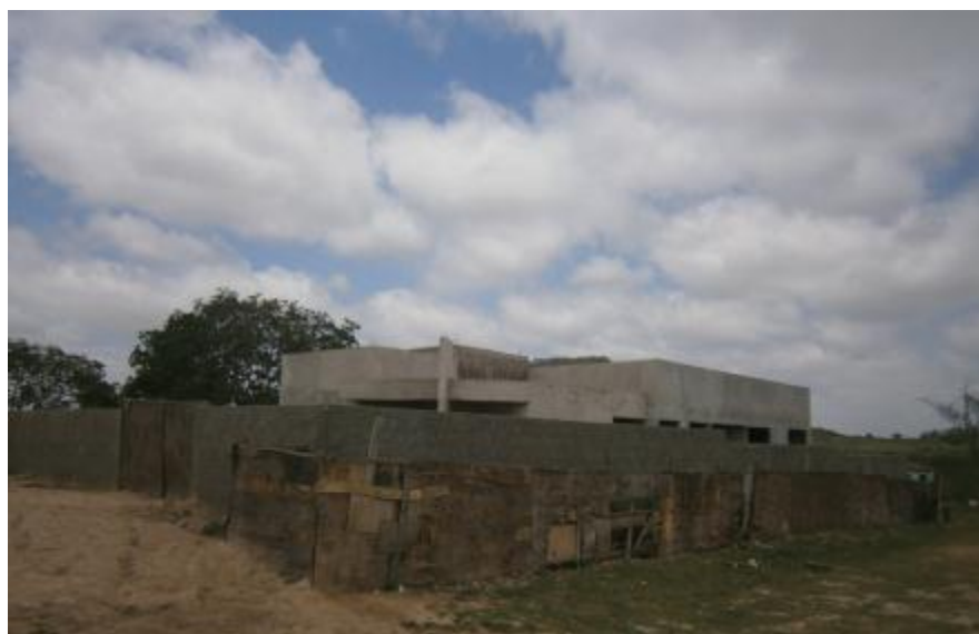
Foto 14: CRAS em processo de construção no Loteamento Santo Afonso II.
