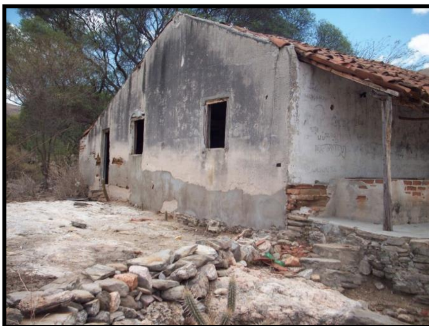
Figura 62: Percurso II – Casa abandonada localizada na trilha por caminhada de acesso ao Percurso II do Trajeto A (Po IV - Figura 52).
