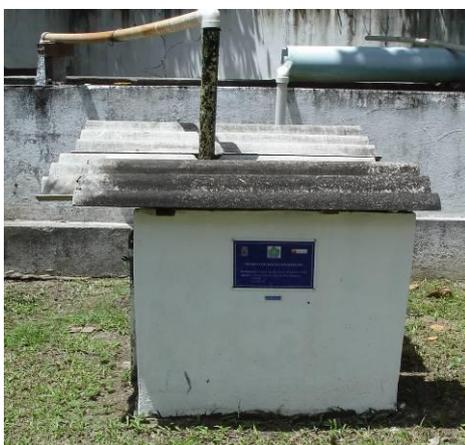
Com 15 m de profundidade (filtro fica entre 6 e 13 m) e 6 polegadas de diâmetros, o poço de produção 1 opera durante 24 h com uma vazão média de 12,6 m<sup>3</sup>/h. Está localizado quase ao centro da EE de Caixa d'Água à aproximadamente 65 m do rio Beberibe.
