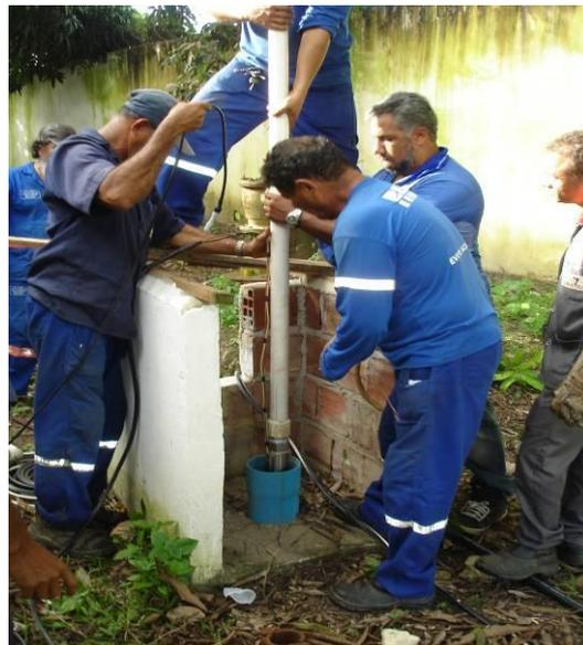
Os poços 02, 03 e 04 possuem diâmetro de 150 mm, 15 m de profundidade, seção de filtro a partir dos 6 m até 12 m de profundidade, seção de pré-filtro
