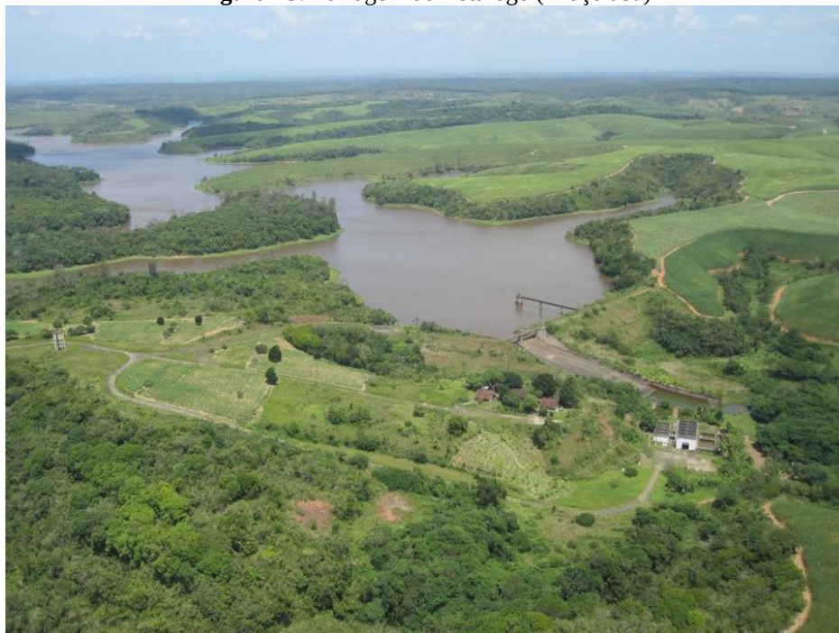
Figura 45: Barragem de Botafogo (Araçoiaba)
