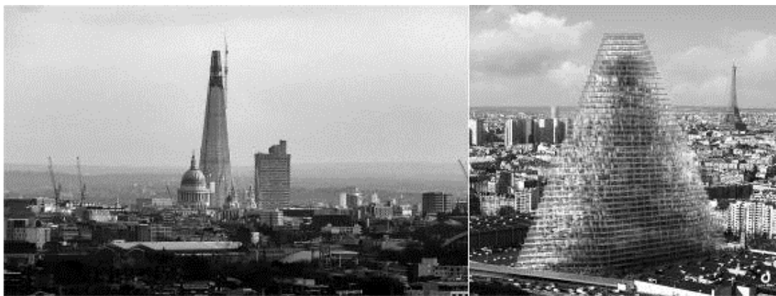
Figuras 39 e 40 – Torre Shard em Londres, projetada por Renzo Piano, com interferência visual sobre a Catedral Saint Paul e Torre Triângulo em Paris, projetada por Jacques Herzog e Pierre de Meuron, situada no Sítio Histórico da cidade, disputa com a Tour Eiffel a condição de marco na cidade. Fontes: < http://www.hampstead-heath.org.uk/?p=25 >; < http://itisaboutdesign.com/blog/2012/04/paris-2020-tour-triangle/ > Acesso junho/2012 (originais em cores).
