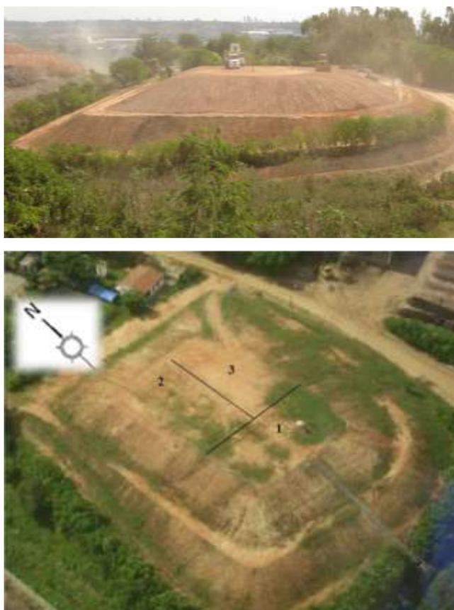
Figura 3.1. Célula experimental construída no aterro controlado da Muribeca/PE (Maciel, 2009)
