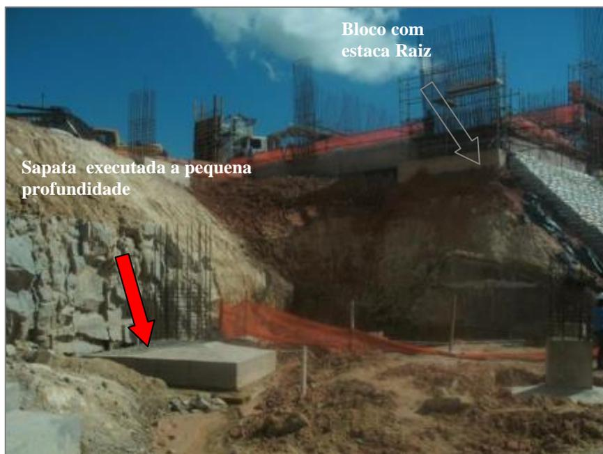
Figura 6. Sapatas e Estaca Raiz executadas
