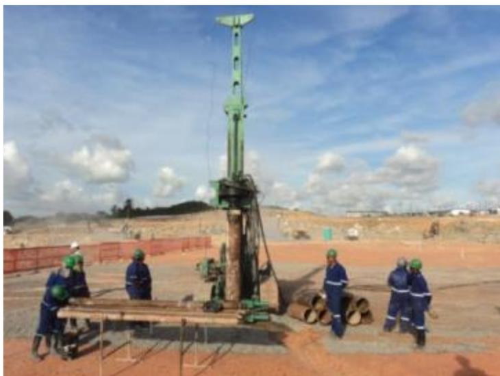
Figura 25. Perfuração de estaca raiz em solo.
