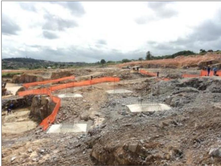
Figura 5. Sapatas construídas a superfície e em pequenas profundidades.
