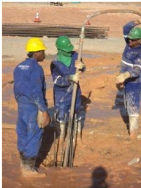
Figura 27. Detalhe do tubo de injeção, instalado no interior do revestimento.
