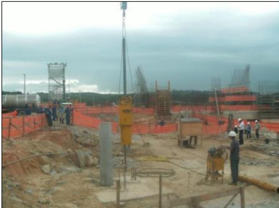
Figura 53. Equipamento do ensaio de carregamento dinâmico
