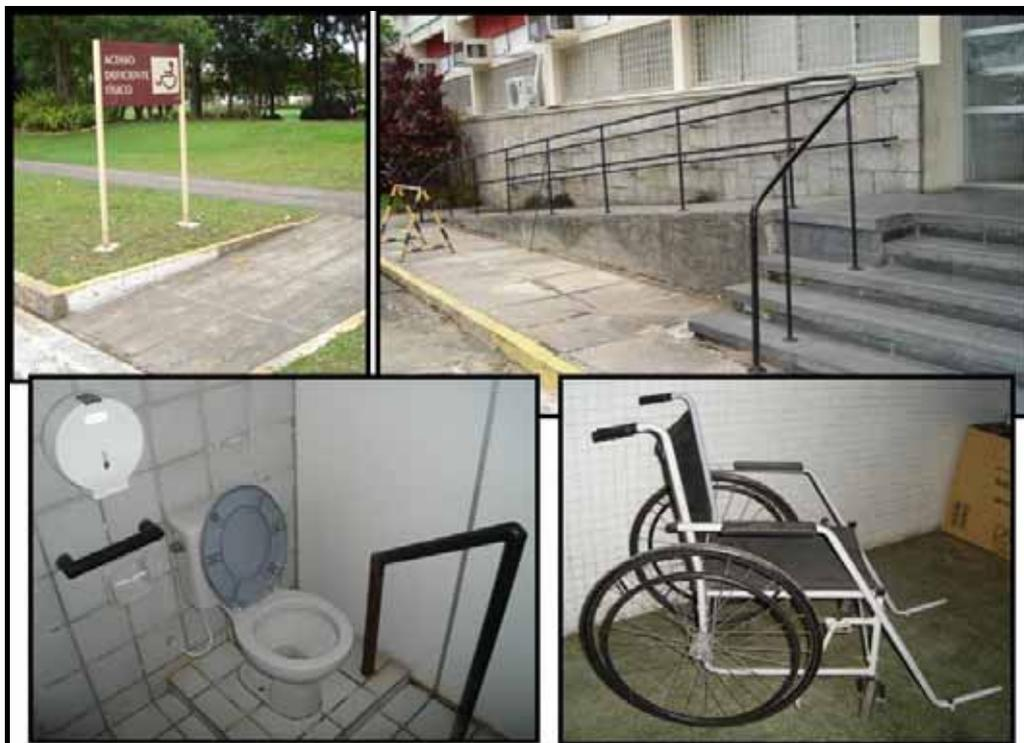
Figura 11 (4): Rampas de acessibilidade (imagens superiores), banheiro adaptado e cadeira de rodas.
