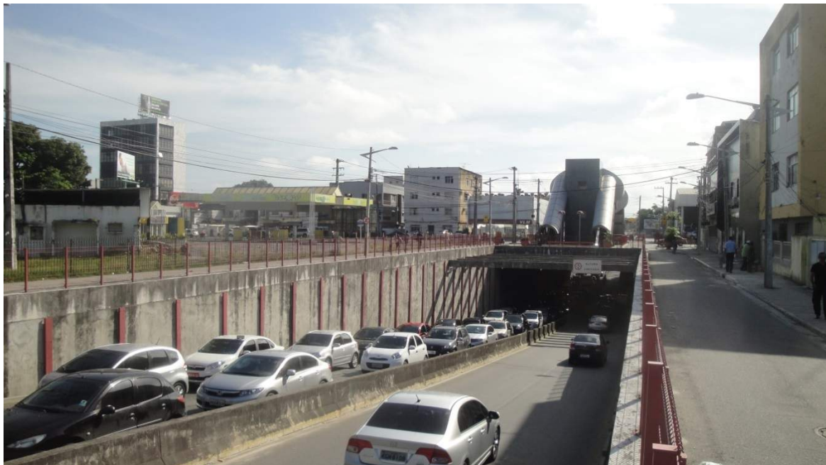
FIGURAS 13 – Via Mangue (Túnel do Pina)
