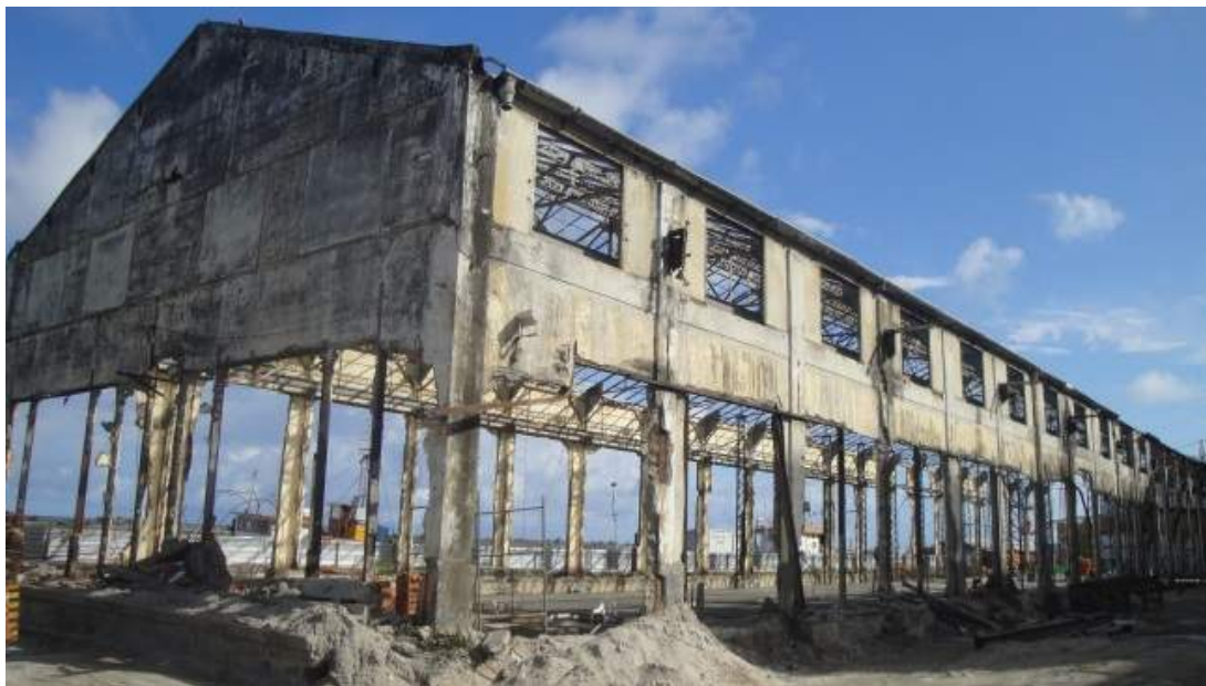
Figuras 19: Demais armazéns em reforma. FONTE: BARBOSA, David Tavares. Trabalho de Campo, janeiro de 2014.
