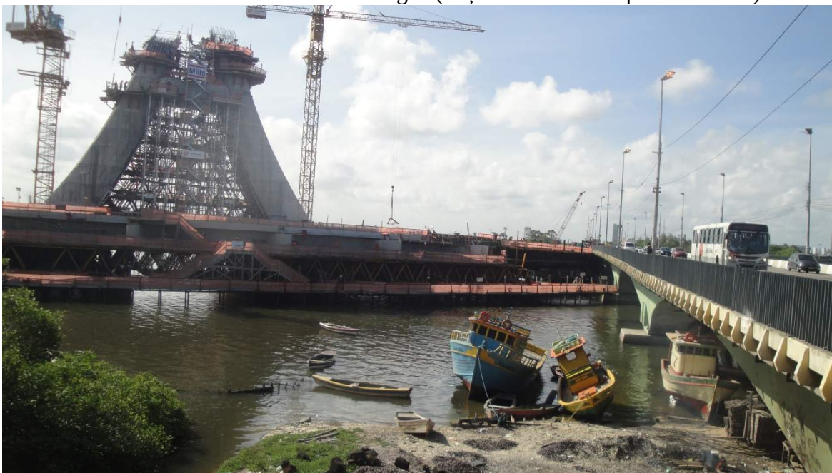
FIGURAS 14 – Obras da Via Mangue (Alça do Viaduto Capitão Temudo)
