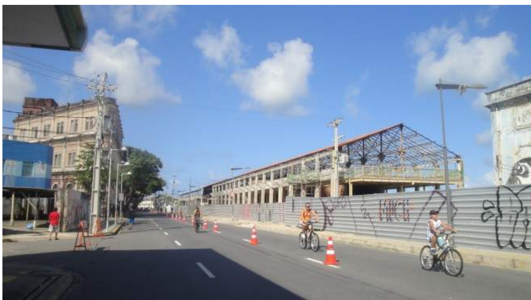
Figuras 20: Demais armazéns em reforma. FONTE: BARBOSA, David Tavares. Trabalho de Campo, janeiro de 2014.
