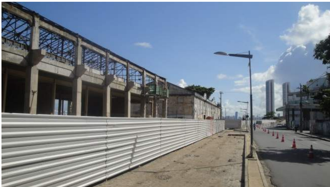
Figuras 21: Armazéns em reforma, Ciclofaixas de lazer e torres gêmeas. FONTE: BARBOSA, David Tavares. Trabalho de Campo, janeiro de 2014.
