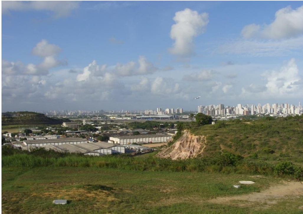
Figura 14 - Vista do Parque e do seu entorno
