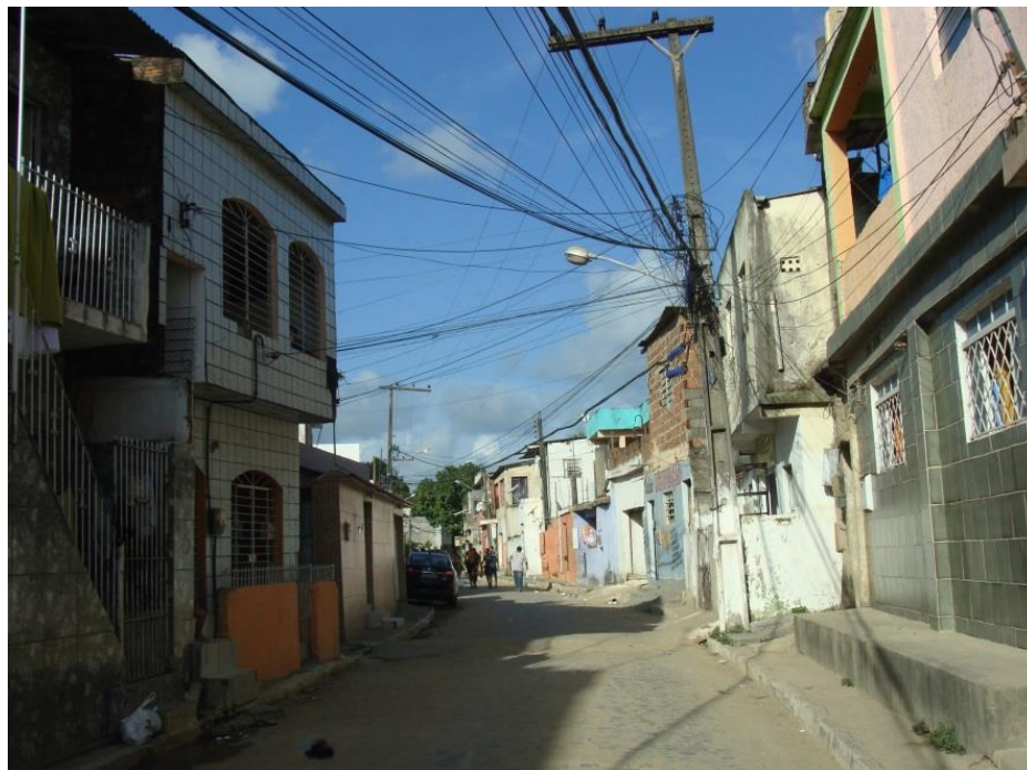
Figura 20 - Vista do interior do assentamento habitacional
