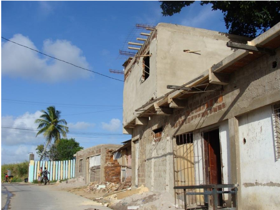
Figura 21 - Vista do interior do assentamento habitacional
