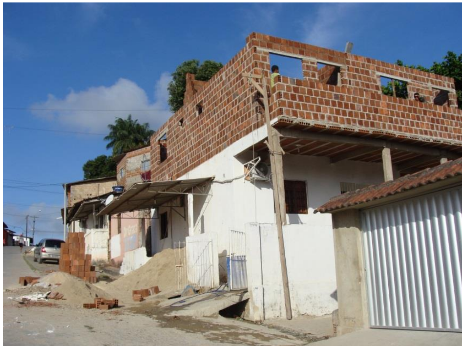
Figura 22 - Vista do interior do assentamento habitacional
