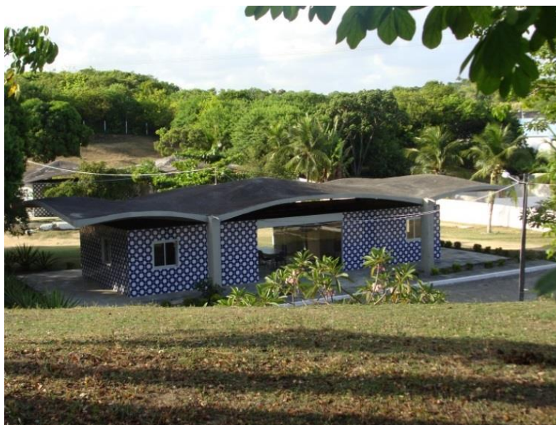
Figura 32 - Sede administrativa do Parque Guararapes
