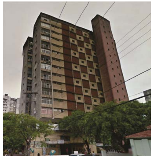
Figura 2.4. Edifício Walfrido Antunes, projeto de Waldecy Fernandes Pinto.
