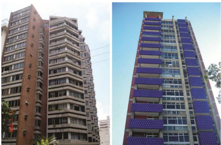
Figura 2.6. À esquerda, edifício Mirage, de Acácio Gil Borsoi. À direita, edifício Barão do Rio Branco, de Delfim Amorim.
