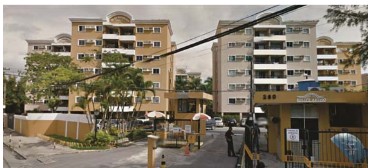
Figura 2.10. Conjunto de edifícios Morada Recife Antigo, projeto dos arquitetos Waldecy Pinto, Carlos Roberto Lins e Marcia Lima.
