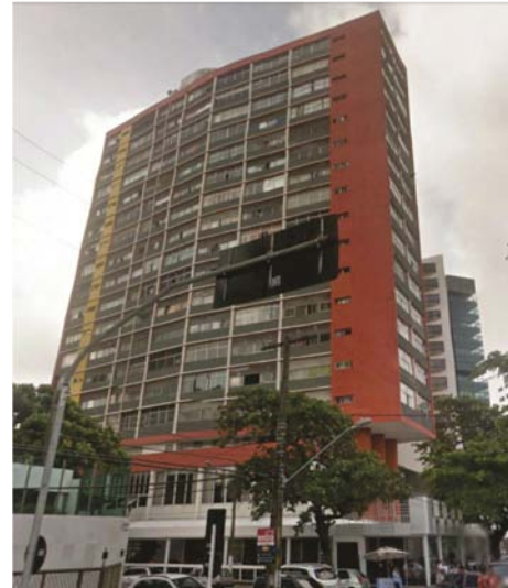
Figura 2.2. Edifício Califórnia, projeto de Acácio Gil Borsoi.
