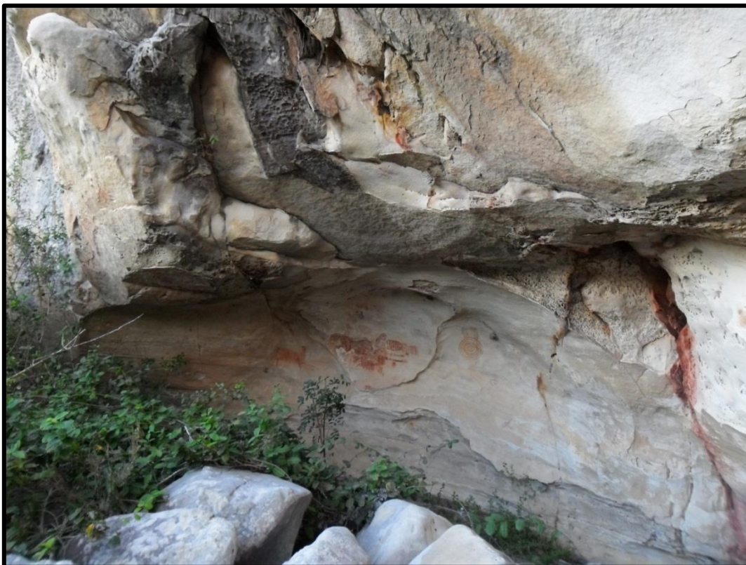
Figura 7: Desabamento de blocos + corrosão da rocha; Sítio do Veado, Buíque - PE. Foto: R.B.
