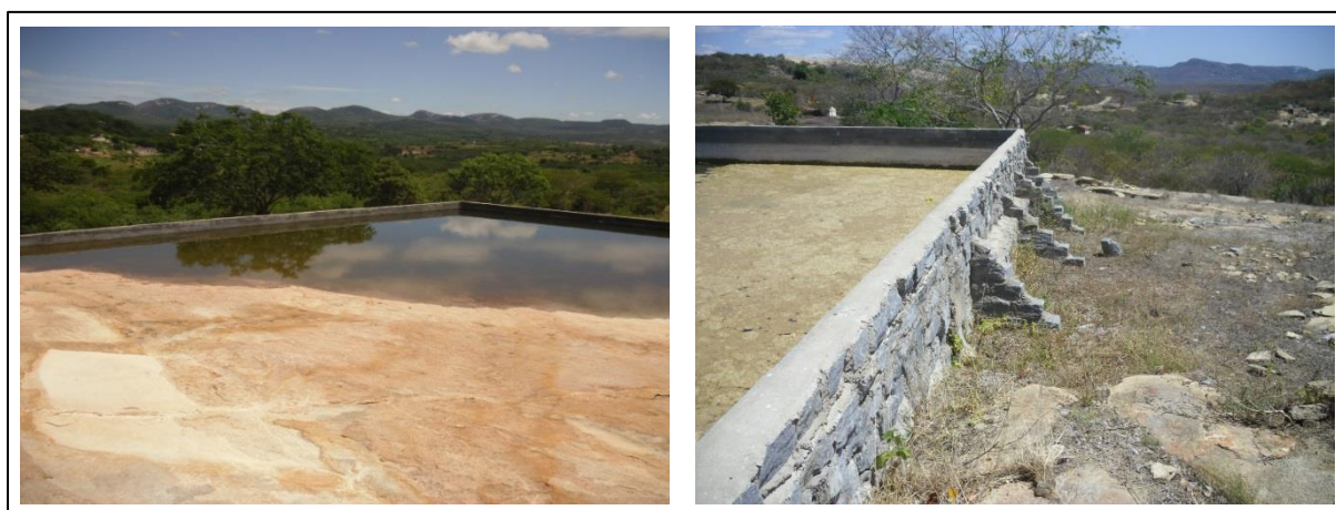
Figura 29 – Tanque de pedra em Afogados da Ingazeira
