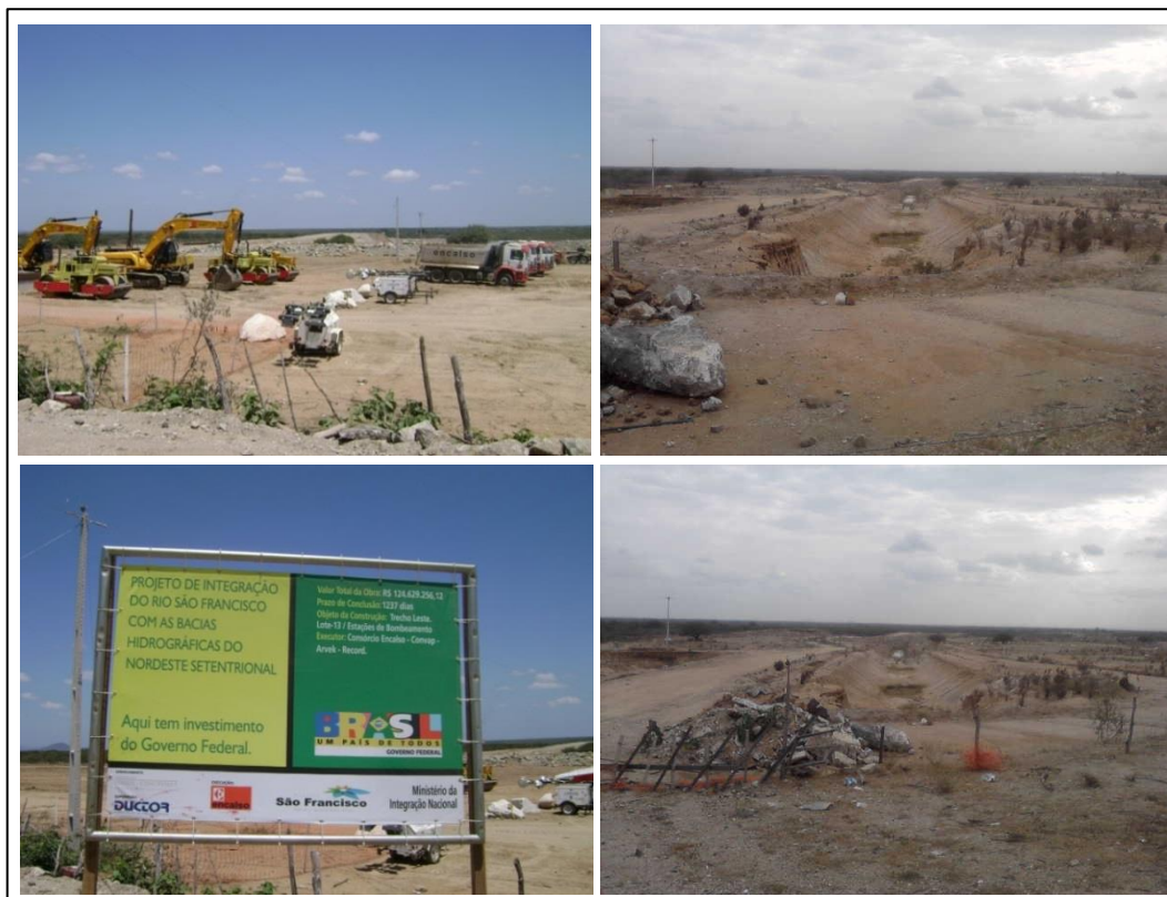
Figura 51 – Obras da transposição do rio São Francisco, em Sertânia – PE, em 2010 (à esq.) e em 2013 (à dir.)
