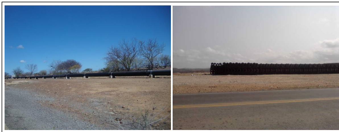
Figura 42 – Obras da Adutora do Pajeú em Afogados da Ingazeira
