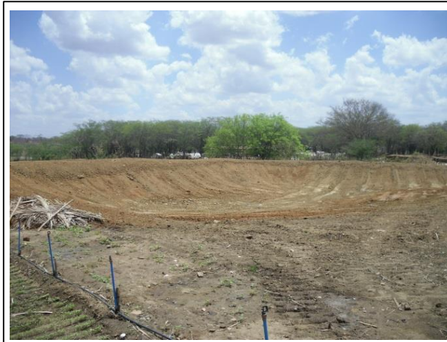
Figura 43 – Escavação de barreiro em Afogados da Ingazeira
