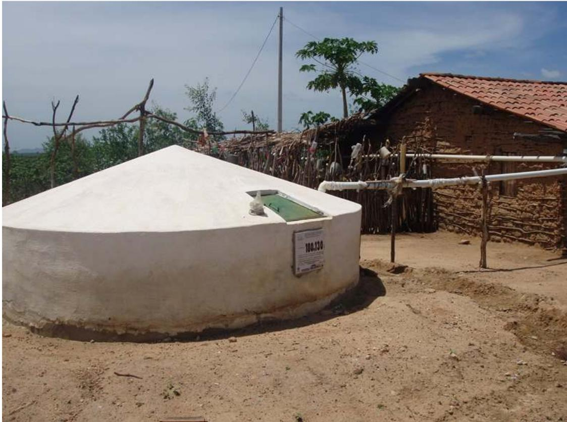
**Figura 51:** Cisterna instalada junto a uma construção de casa de taipa, edificação típica da região.
