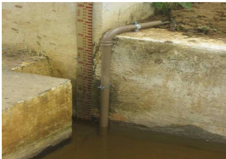
Figura 8. Instalação do sensor de nível.
