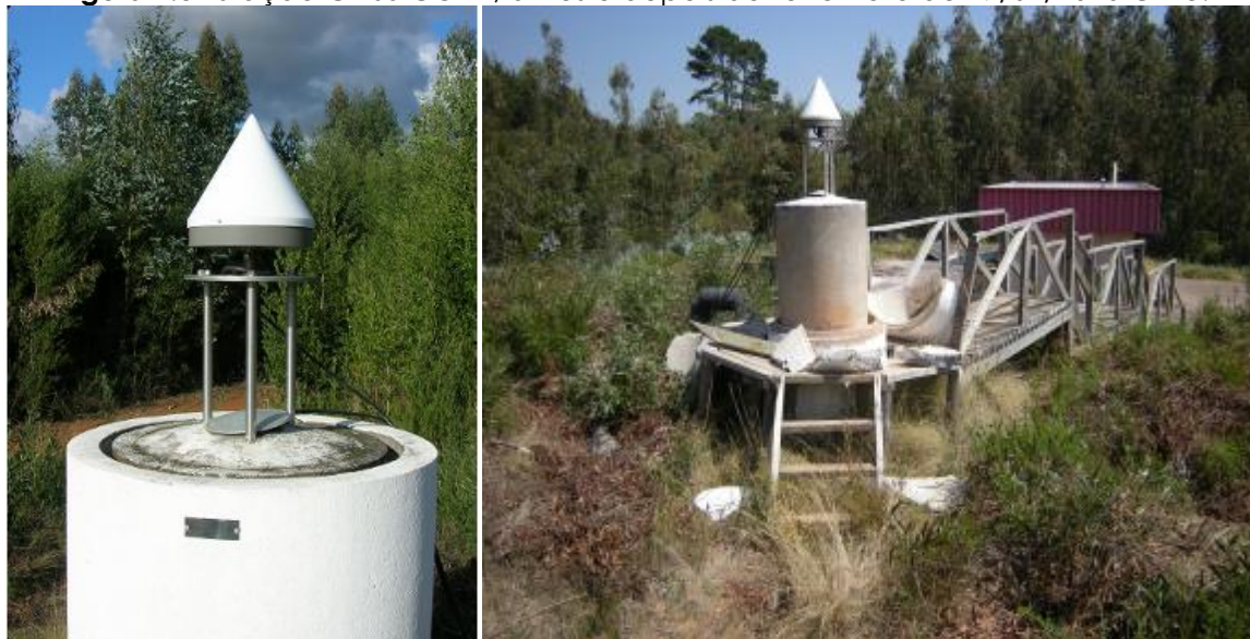
Figura 4.3 Estação GNSS CONZ, antes e depois do terremoto de 27/02/2010 Chile.
