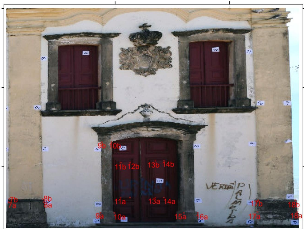
Figura 29: Distribuição dos Pontos na Fachada
