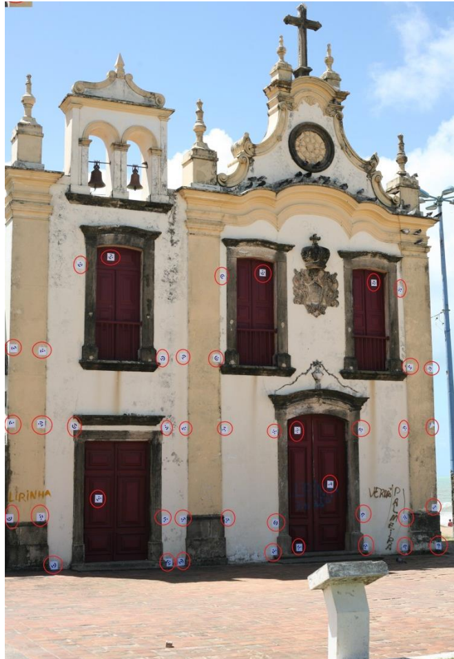
Figura 26: Distribuição dos alvos codificados na fachada
