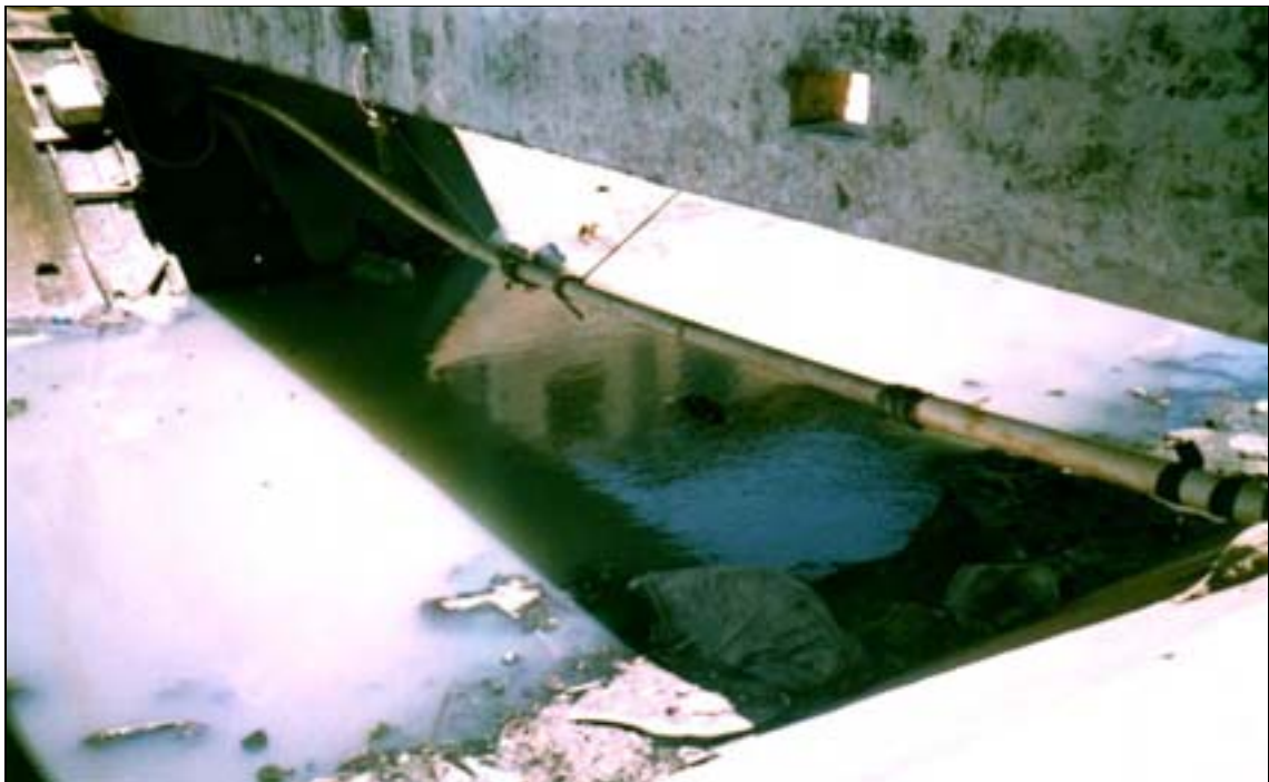
Foto 07: Imagem do cano furado embaixo do canal
