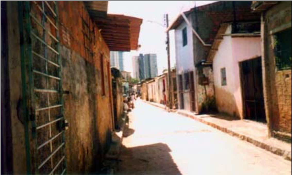
Foto 06: Entrada da rua Jordânia (observar os prédios ao fundo)
