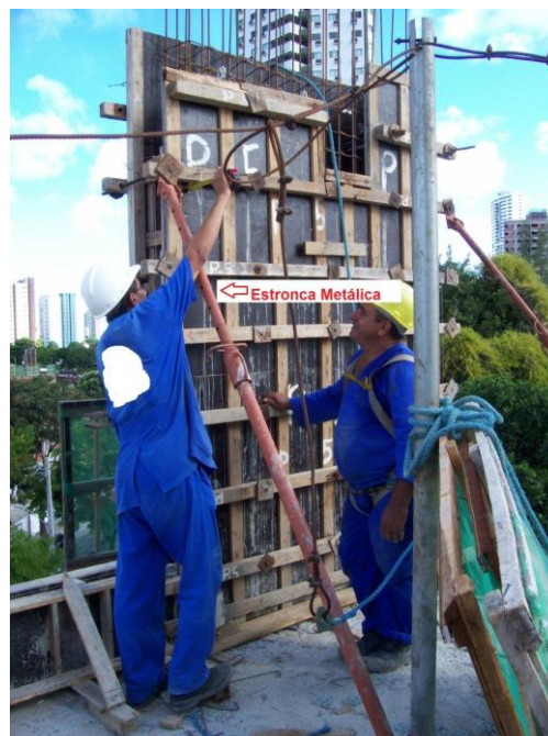
Figura 33 – Verificação da verticalidade na parte superior do madeirite utilizando a trena, o prumo de centro e a estronca metálica.
