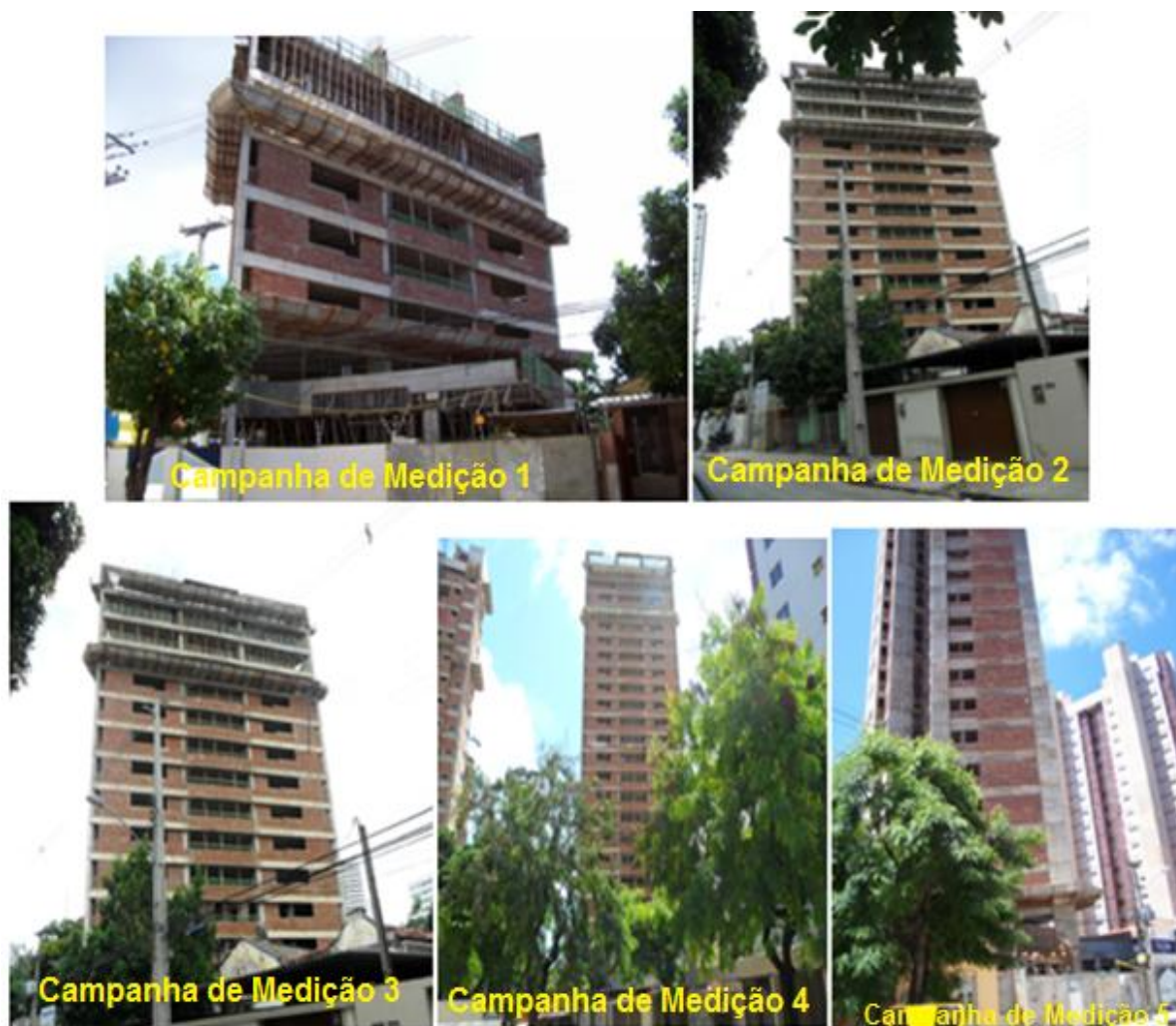
Figura 40 – Andamento da edificação em relação às campanhas de medição.
