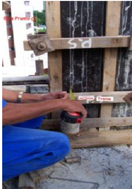
Figura 30 – Verificação da verticalidade na parte inferior utilizando a trena e o prumo de centro.
