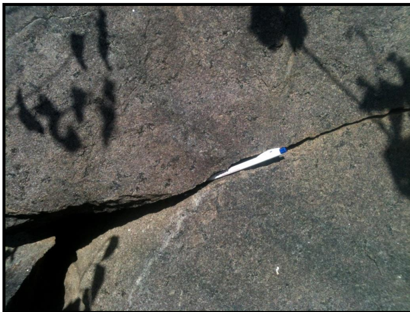
Figura 09 – Detalhe de fratura. Fonte: Autor, 2012.
