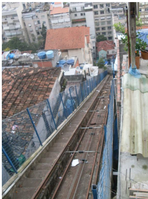
Figura 11 – Vista do plano inclinado que dá acesso ao Pavão-Pavãozinho
