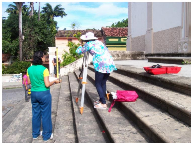
Figura 4.27 – Mira de Vante sobre um ponto auxiliar materializado por uma sapata e primeira estação de nivelamento. Foto: Julho 2011.
