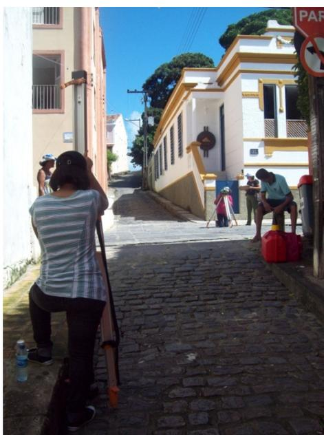
Figura 4.41 – Lance de Ré da última estação da linha de nivelamento L8 (caminhamento da RNLSE para RNPM). Foto: Julho 2011.
