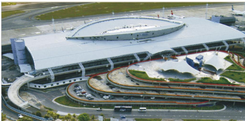
GERENCIAMENTO E FISCALIZAÇÃO DAS OBRAS DE AMPLIAÇÃO E REFORMA DO TERMINAL DE PASSAGEIROS E EDIFÍCIO GARAGEM DO NOVO AEROPORTO INTERNACIONAL DOS GUARARAPES, RECIFE/PE.
