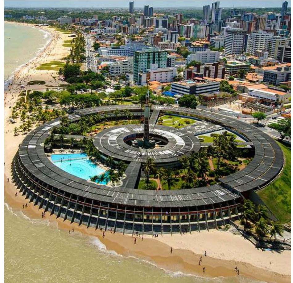
Figura 02: Hotel Tambaú, João Pessoa (PB)
