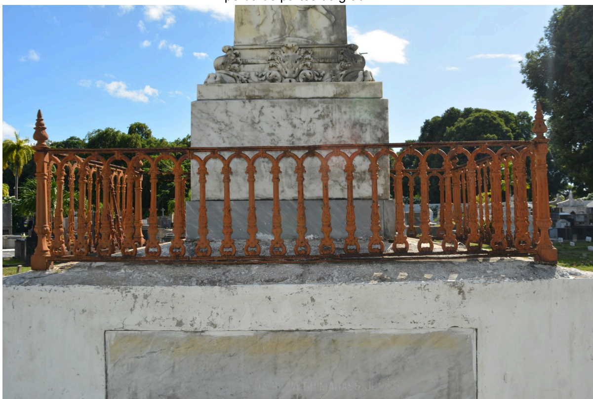
Figura 21 – Gradil Q14 F13, em estado Péssimo, com danos e corrosões em estágios avançados e perda de partes do gradil.
