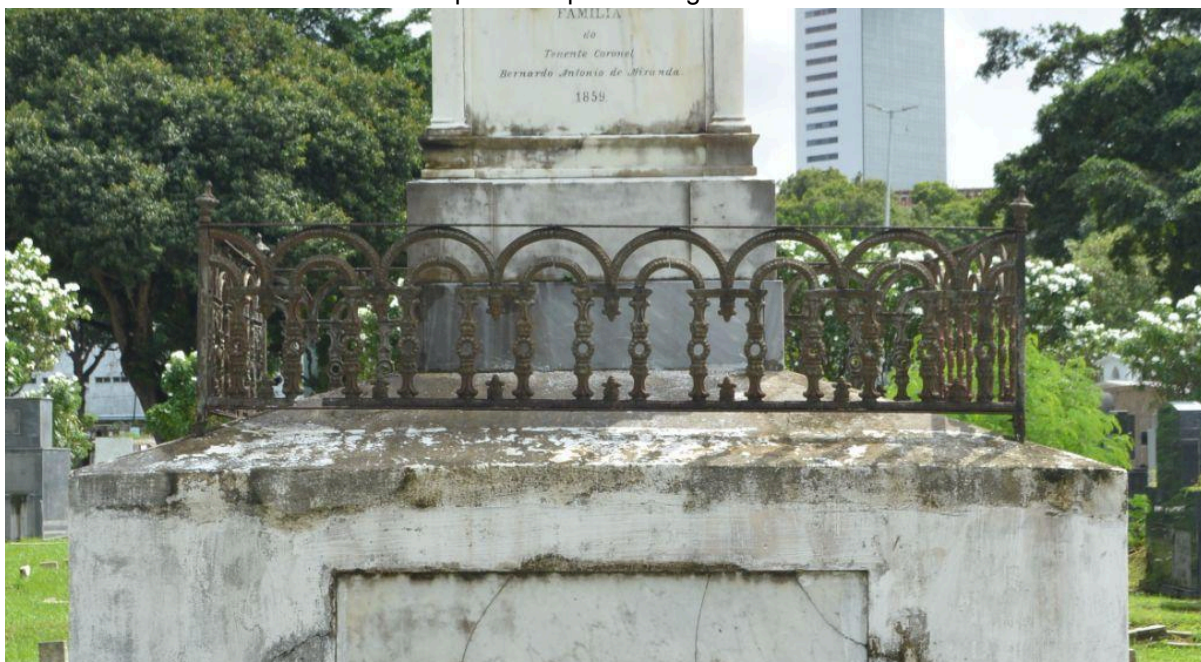
Figura 23 – Gradil Q40 F17, em estado Péssimo, com danos e corrosões em estágios avançados e perda de partes do gradil.
