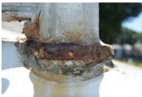
Figura 21 – Gradil Q14 F13, em estado Péssimo, com danos e corrosões em estágios avançados e perda de partes do gradil.
