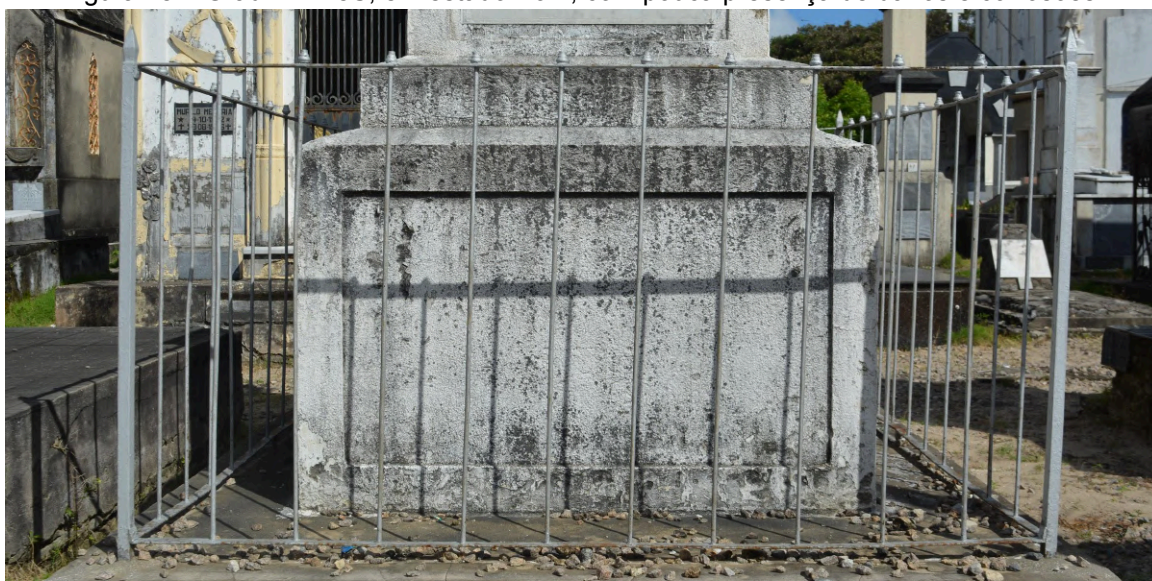
Figura 28 – Gradil R2N8S, em estado Bom, com pouca presença de danos e corrosões.
