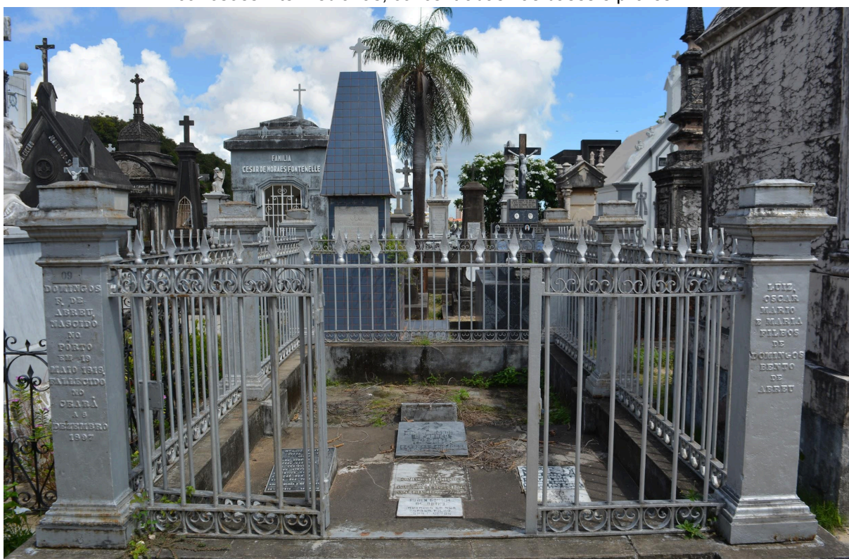
Figura 32 – Gradil R3N9N, em estado Ruim, com danos mais graves (Deformação e Quebra) e corrosões intermediárias, concentradas nas bases e pilares.
