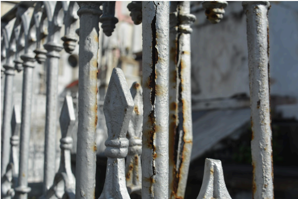
Figura 41 – Fissura associada ao descascamento da tinta na junção de dois módulos.
