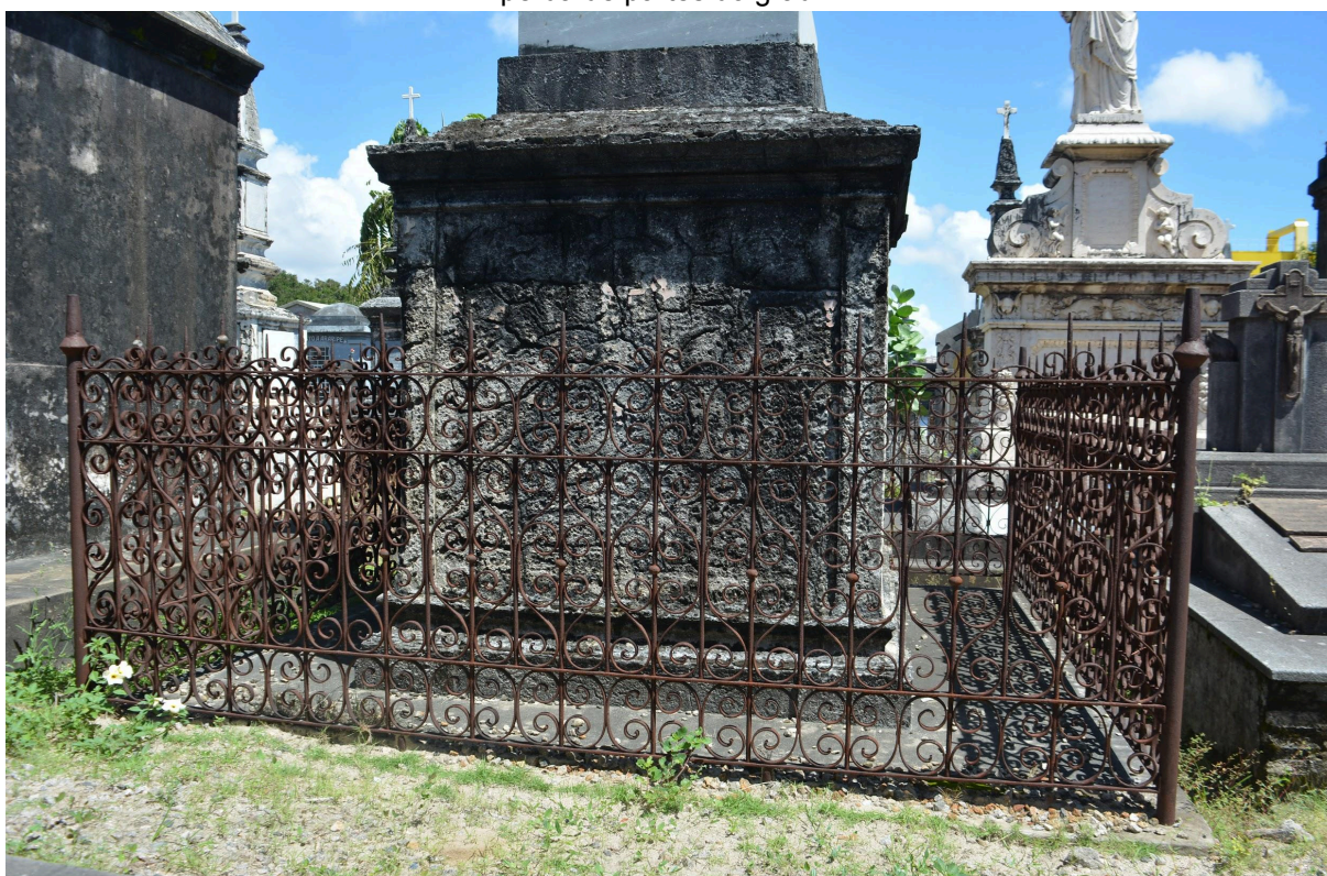
Figura 36 – Gradil R4N19N, em estado Péssimo, com danos e corrosões em estágios avançados e perda de partes do gradil.
