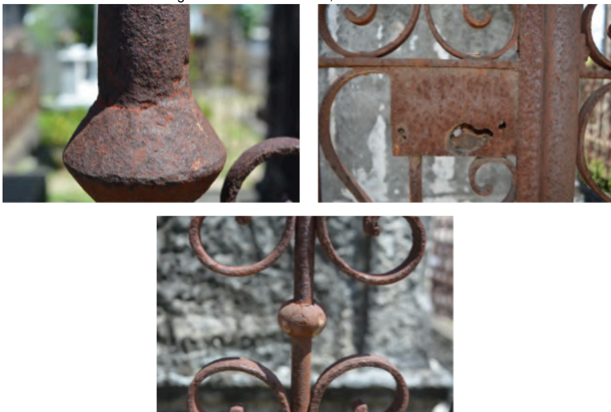
Figura 37 – Gradil R4N19N, danos em detalhe.
