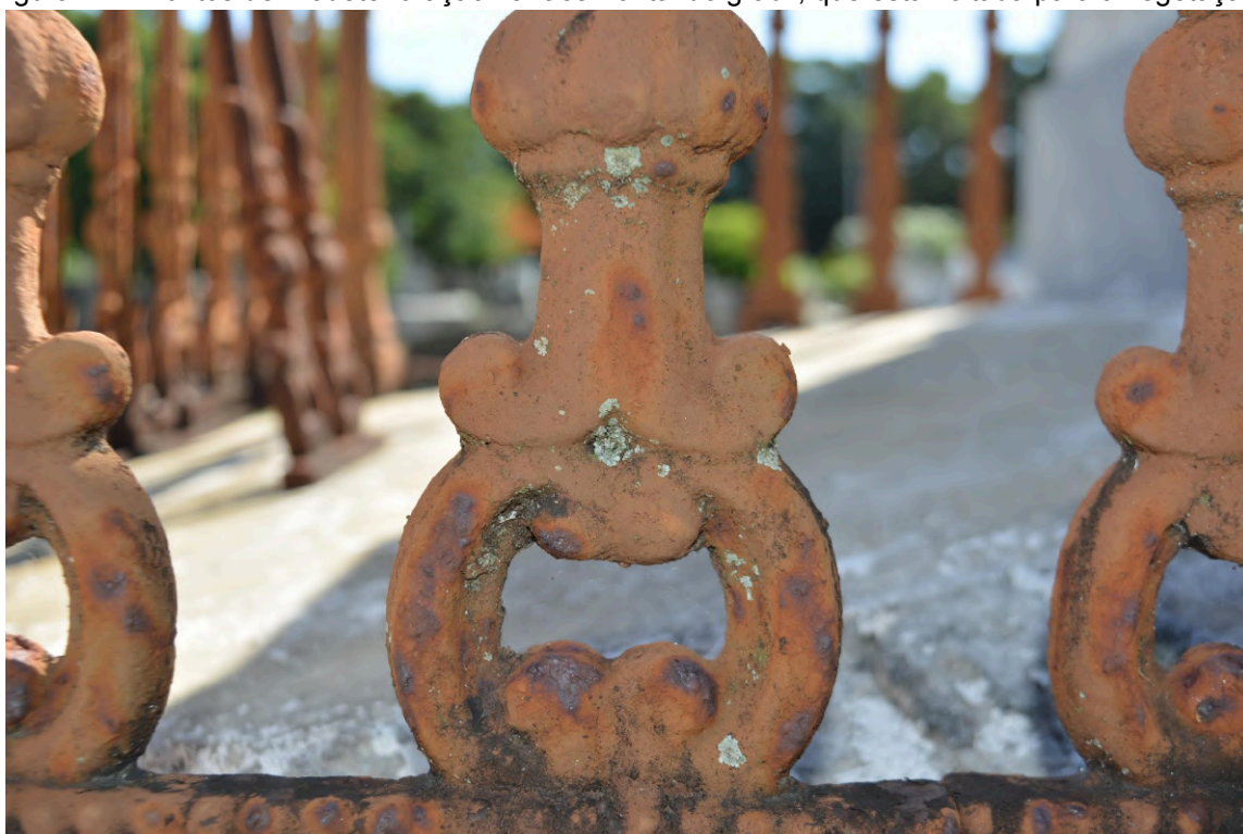
Figura 42 – Pontos de Biodeterioração na face frontal do gradil, que está voltada para a vegetação.
