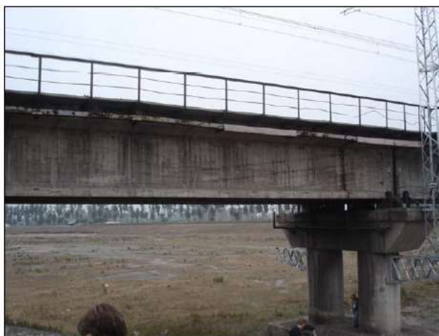
Figura 13 - Fissuração em ponte paralela ao cabo de protensão.
