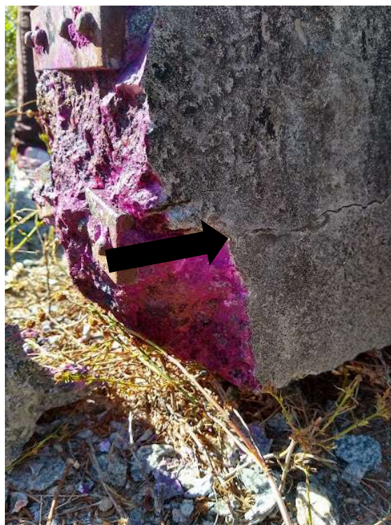
Figura 14 - Fissuração longitudinal nos dormentes
