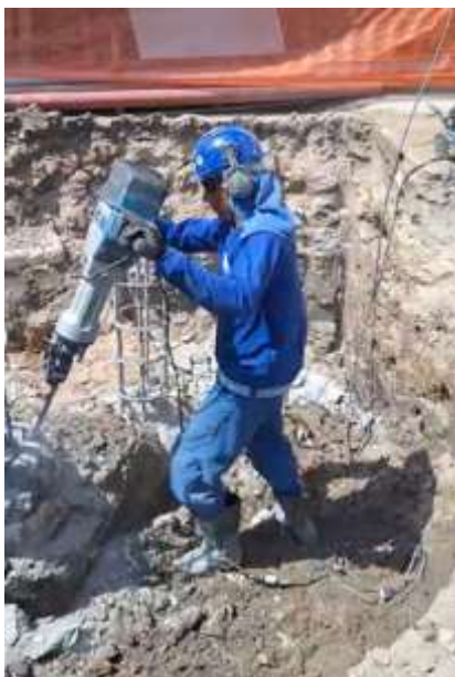
Figura 37 – Servente arrasando estaca com martelete
