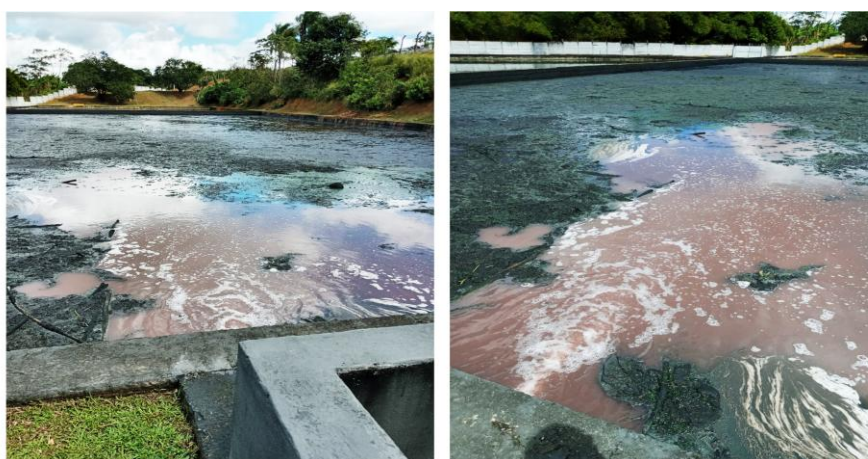
Figura 5. Superfície da lagoa de tratamento 1 apresentando espessa camada de matéria orgânica, óleos e graxas em sua superfície, além de zonas mortas
