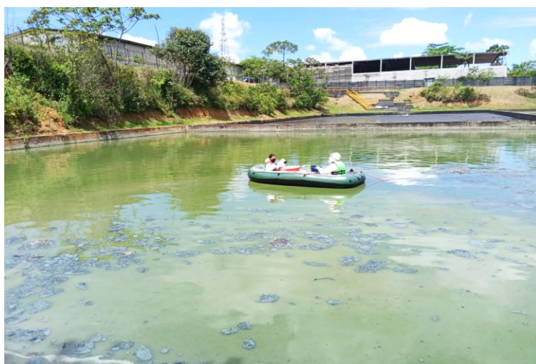
Figura 2. ETE multifábril do Jaboatão dos Guararapes
