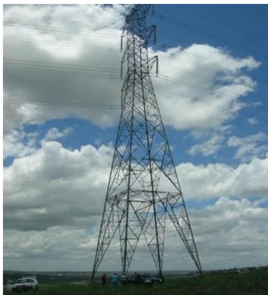
Figura 4-29- Vista geral da torre autoportante da linha de transmissão de 230 kV Campina Grande II / Pau Ferro, selecionada para realizar testes de radiografia computadorizada de alta energia utilizando o betatron.
