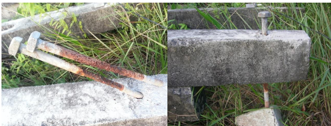
Figura 4-32- Parafusos na cruzeta de concreto.
