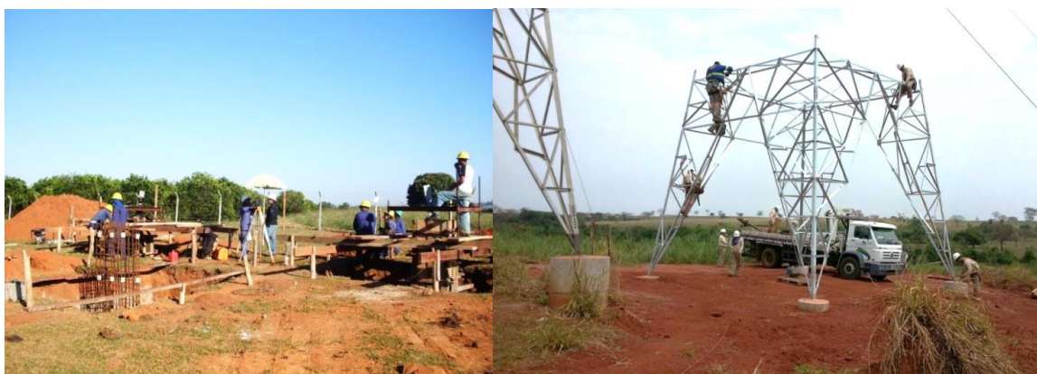
Figura 2-3- Fotos mostrando que as fundações de concreto armado para torres metálicas autoportantes para linhas de transmissão são preparadas nas condições locais.
