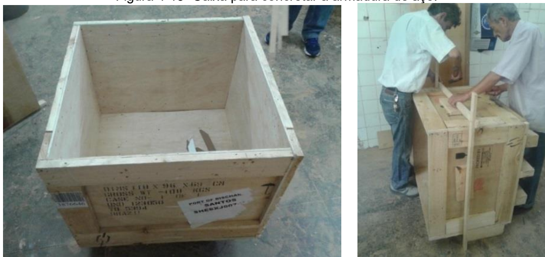
Figura 4-13- Caixa para concretar a armadura de aço.
