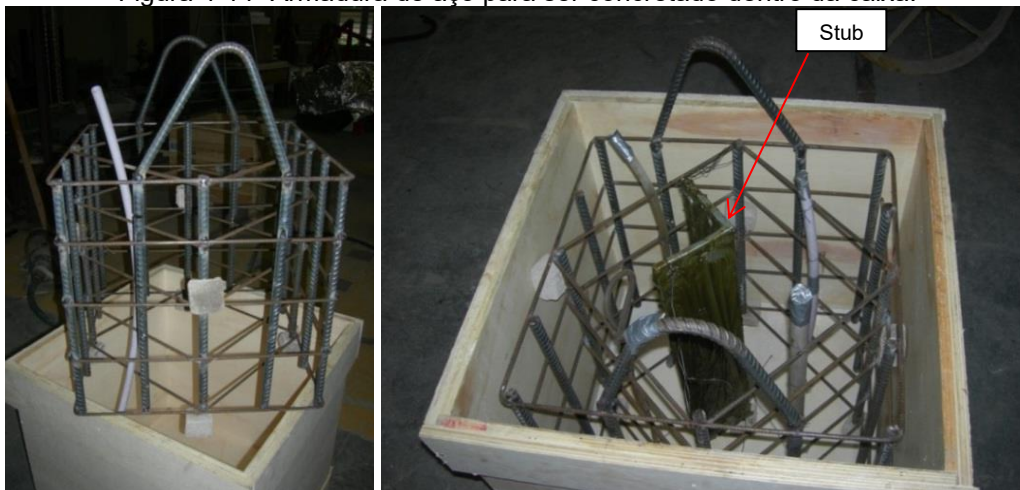
Figura 4-14- Armadura de aço para ser concretado dentro da caixa.
