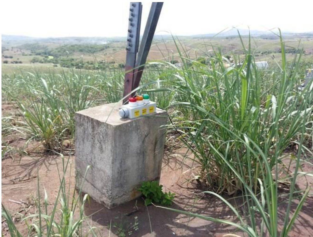
Figura 5-66- Dispositivo sobreposto à outra fundação da base da mesma torre.
