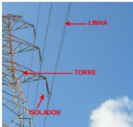
Figura 2-7- Isoladores de compósito em suspensão de uma linha de transmissão de 230 kV.
