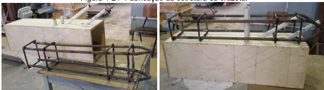
Figura 4-24- Fabricação da estrutura da cruzeta.
