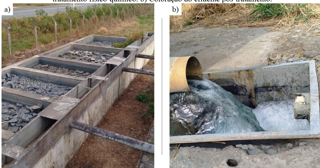
Figura 4 - Estação de tratamento de uma lavanderia de Caruaru, agreste Pernambucano. a) Lodo residual do tratamento físico-químico. b) Coloração do efluente pós-tratamento.
