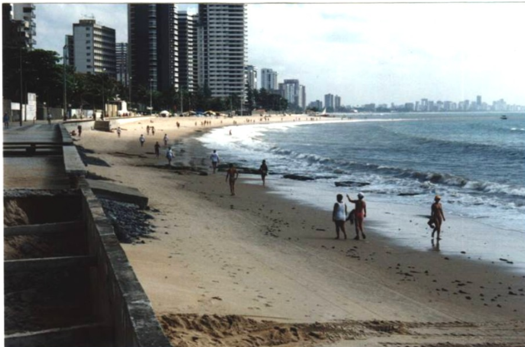
Foto 10 – Exemplo de obra mal sucedida, na Célula 5 (praia das Candeias), no qual um “seawall” associado a rampas de acesso, ocupando a pós-praia e parte do estirâncio, apresenta destruição parcial, agravada pela retirada de areia de sua base, necessitando de pequenos enrocamentos para sua proteção.
