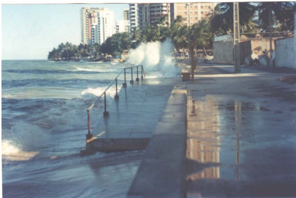
Foto 12 – Outro trecho da Célula 5, com incidência frontal das ondas e arrebatção direta no “seawall”. Em primeiro plano, vê-se a retirada de sedimentos sob a rampa devido à percolação das águas.
