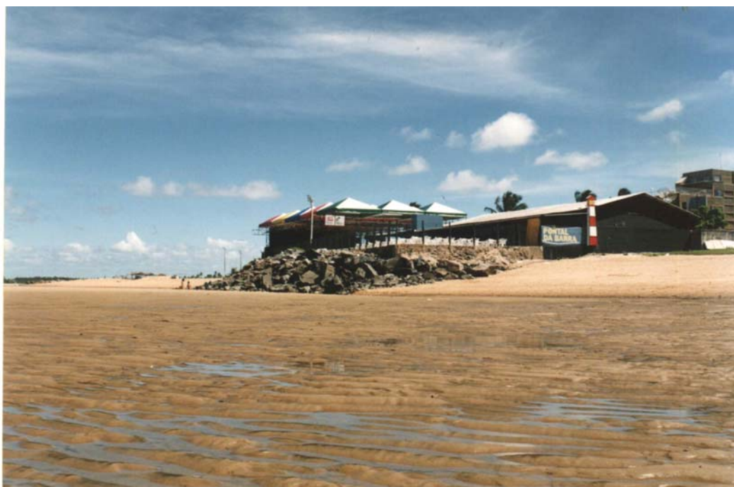
Foto 24 – Detalhe da foto anterior, onde se vê o avanço da construção sobre o setor praial e o enrocamento instalado para sua proteção.
