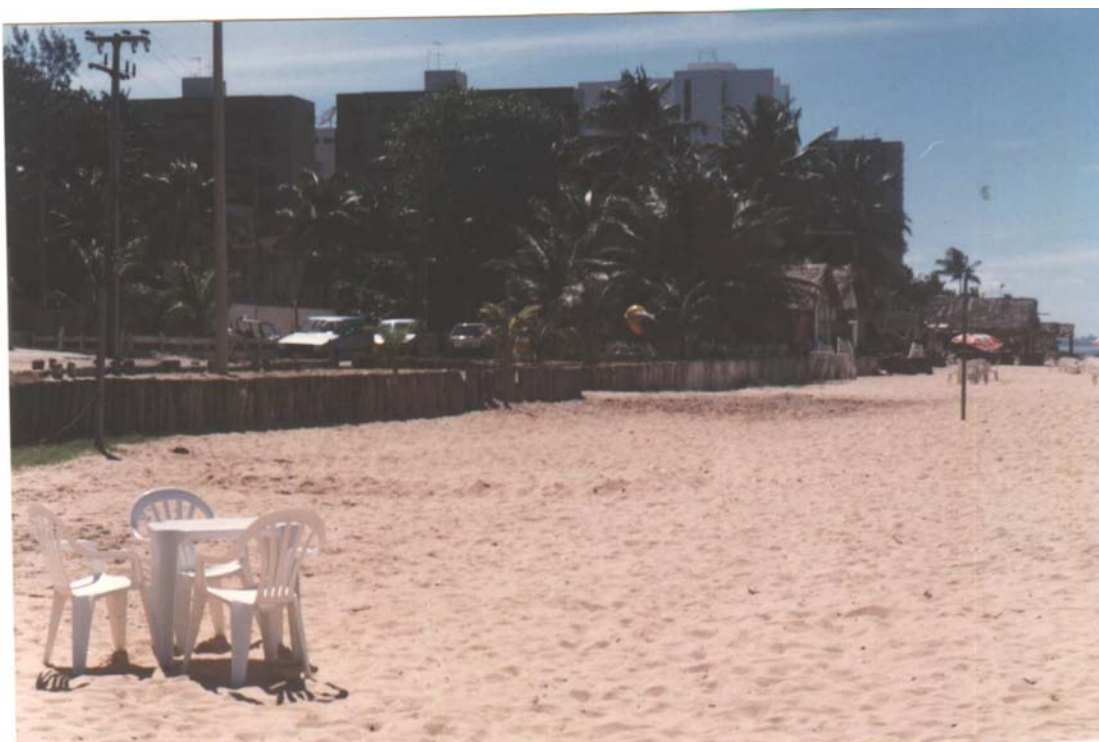
Foto 16 – Muro de troncos de coqueiros na pós-praia, respeitando um recuo em relação à escarpa de berma, permitindo uma estabilidade no ambiente praial (perfil P5 – praia das Candeias).
