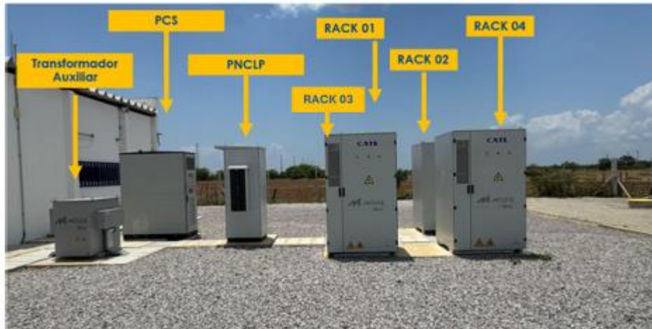
Figura 16 - Distribuição geral dos componentes do BESS de Casa Nova
