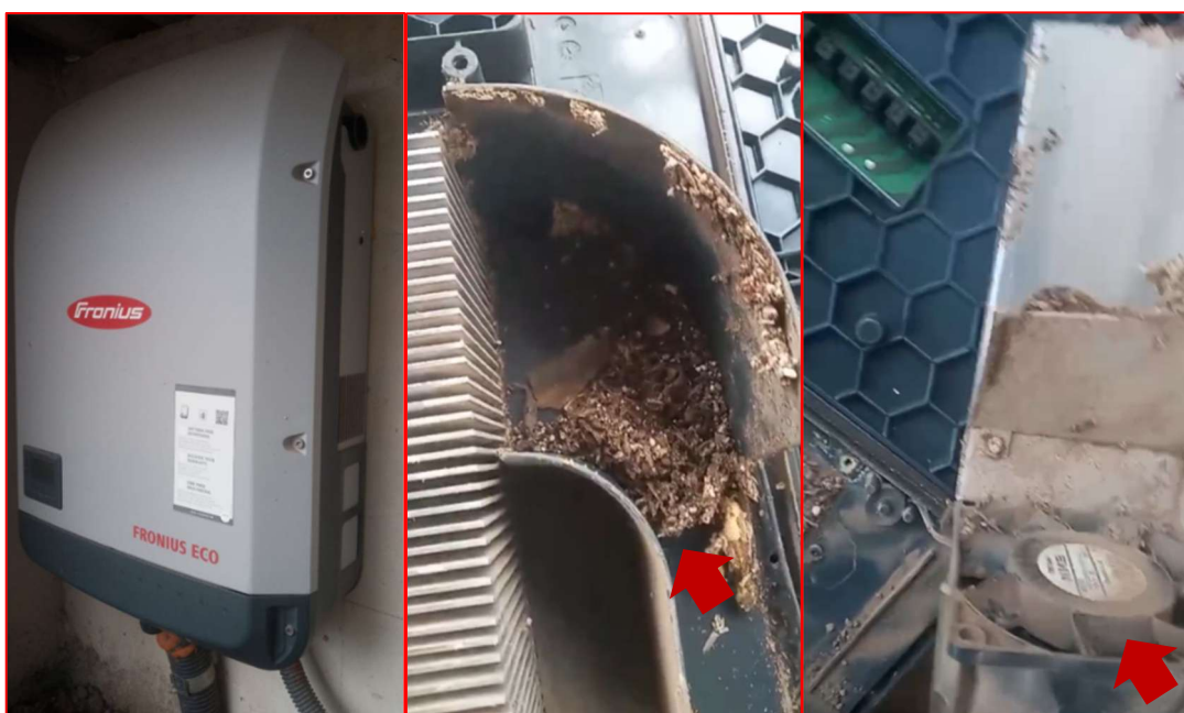
Figura 37: Refrigeração do inversor On-Grid da usina fotovoltaica 03
