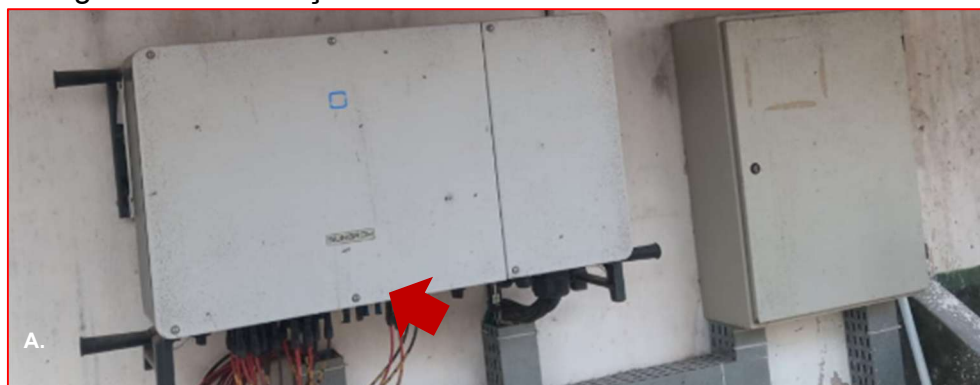
Figura 28: Verificação do inversor On-Grid da usina fotovoltaica
