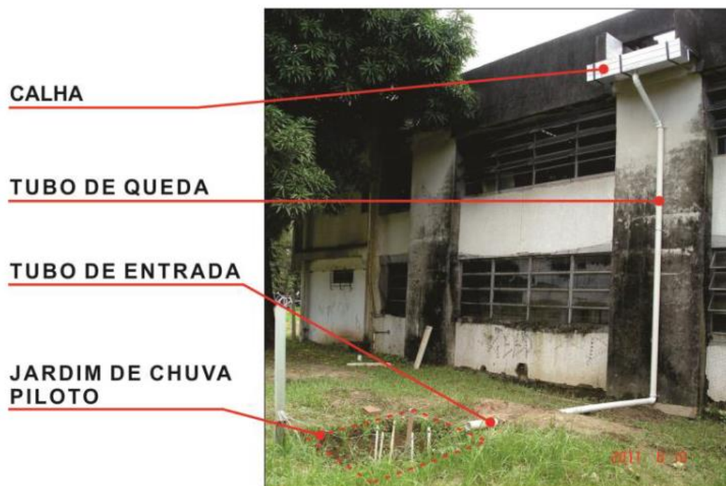
Figura 16: Conjunto para captação das águas superficiais do telhado para o jardim de chuva piloto da UFPE.
