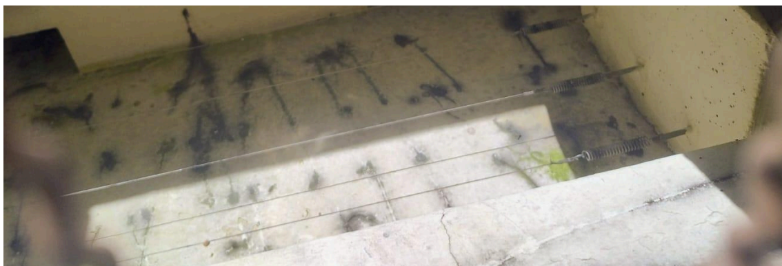
Figura 6 - Fio tensionado anti pombos
