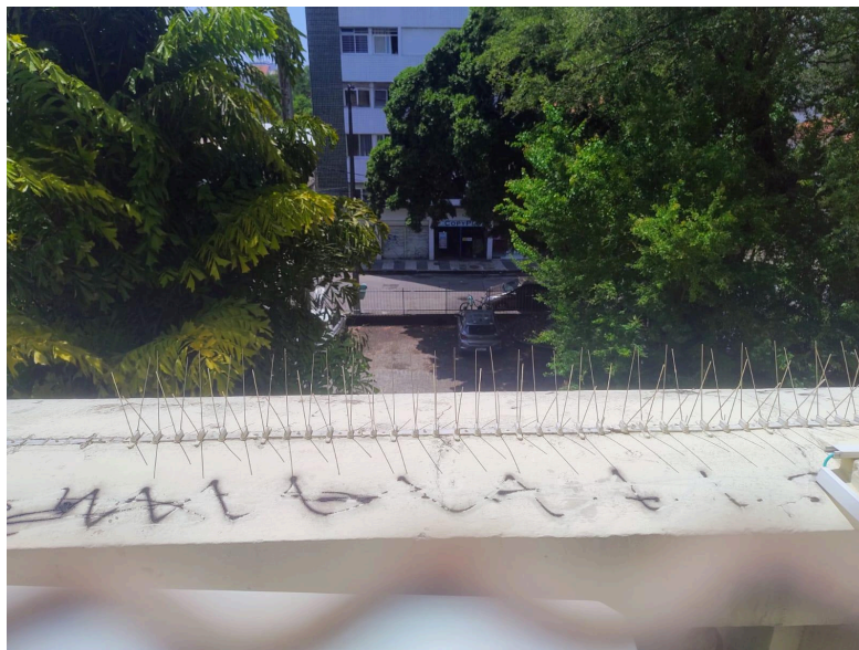
Figura 7 - Espículas anti pombos
