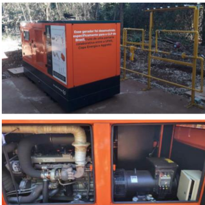
Figura 12 - Gerador LPG95, fabricado pela Leão Energia, utilizado para os experimentos. Na imagem superior é mostrado o GMG fechado em sua cabine. Na imagem inferior é mostrada a imagem com as tampas abertas exibindo o motor MWM 6.12 TCA, à esquerda e o alternador WEG GTA 202-AI36 380/220 V, 60 Hz à direita da imagem.
