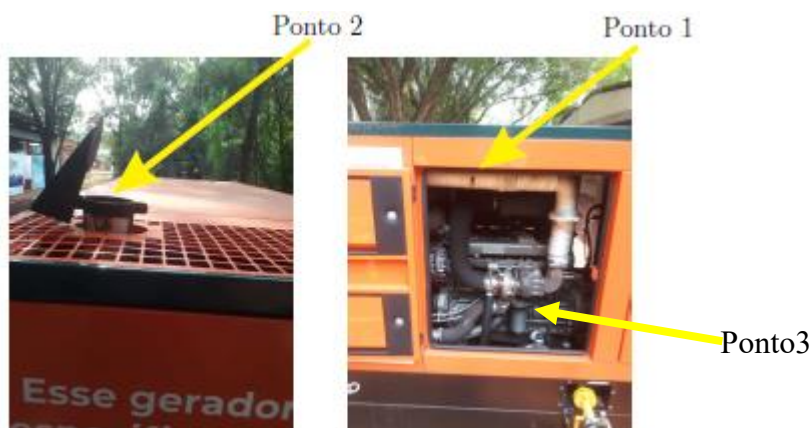
Figura 17 - Pontos do GMG nos quais são realizadas as medições de temperatura dos gases de exaustão (Ponto 1 e 2), temperatura da turbina (Ponto 3) e emissões de escapamento (Ponto 1) do GMG.
