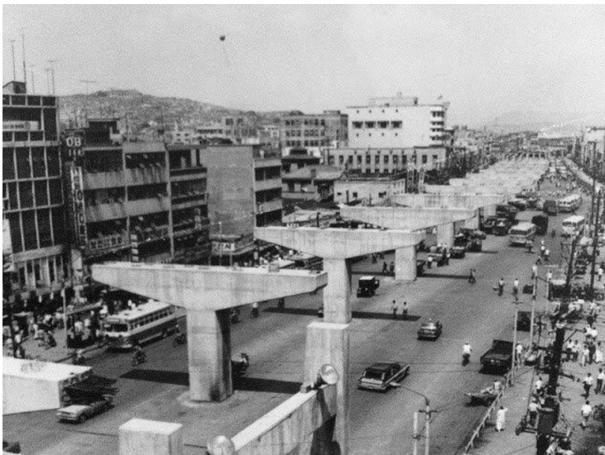
Figura 27: Leito carroçável que encobriu o riacho Cheonggyecheon ainda em fase de construção do viaduto. Fonte: Projeto Batente, sem data.
