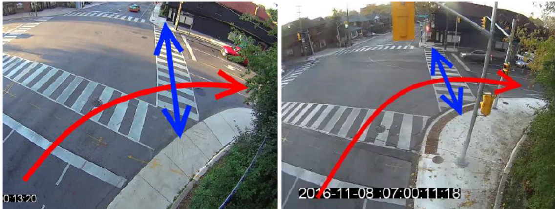
Figura 3 - Antes e depois da construção de ampliação do raio de curvatura na interseção entre as ruas Davenport e Christie em Toronto no Canadá
