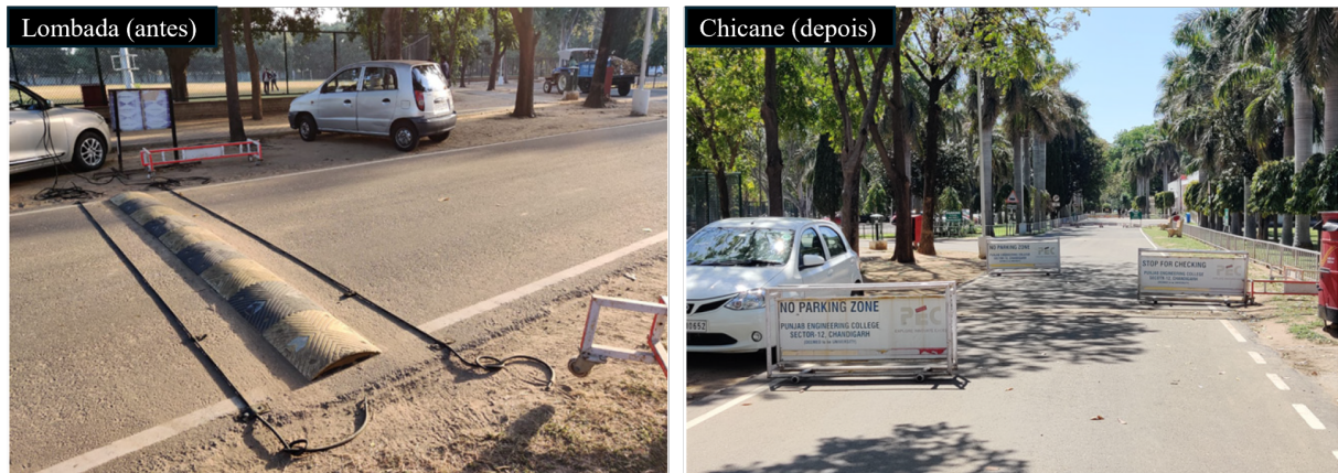
Figura 5 - Ilustração da operação de substituição de lombadas por chicanas na Índia
