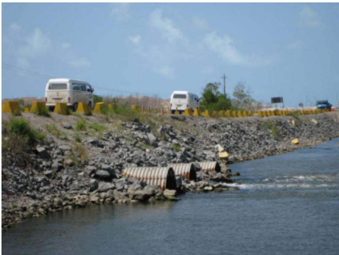
Figura 04: “Passagem” Construída pelo CIPS no rio Tatuoca
