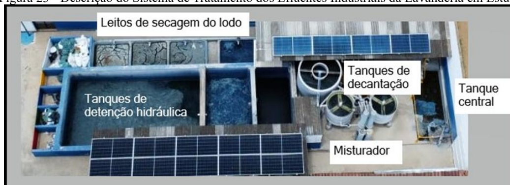
Figura 23 - Descrição do Sistema de Tratamento dos Efluentes Industriais da Lavanderia em Estudo
