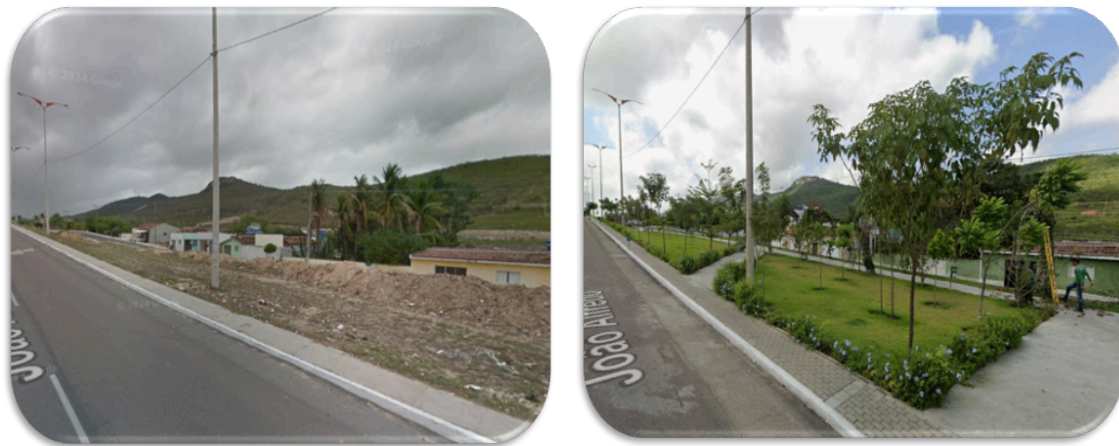
Figura 11 – Vista Av. Conselheiro João Alfredo em Arcoverde-PE (captura de tela do Google Street View).
