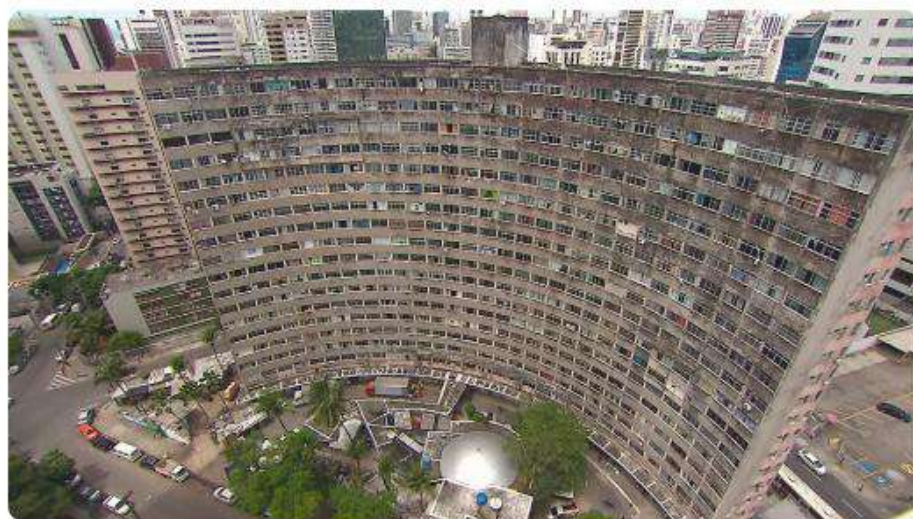
Edifício Holiday fica no bairro de Boa Viagem, na Zona Sul do Recife — Foto: Reprodução/TV Globo
