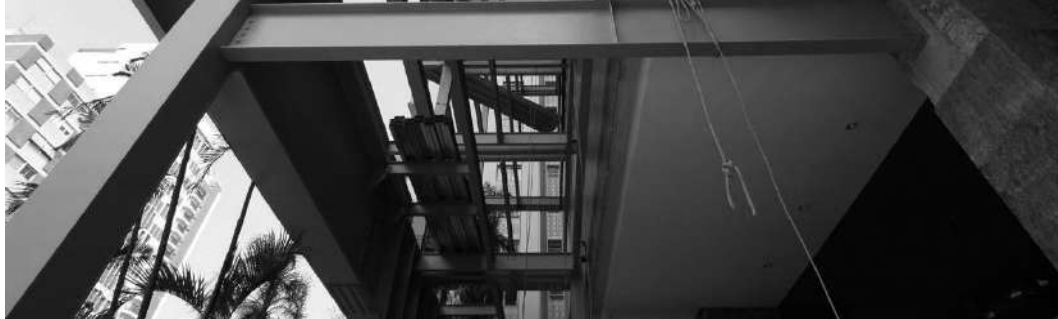
Figura 26: Varandas feitas com estrutura metálica. Fonte: UrbanNext, 2016.
