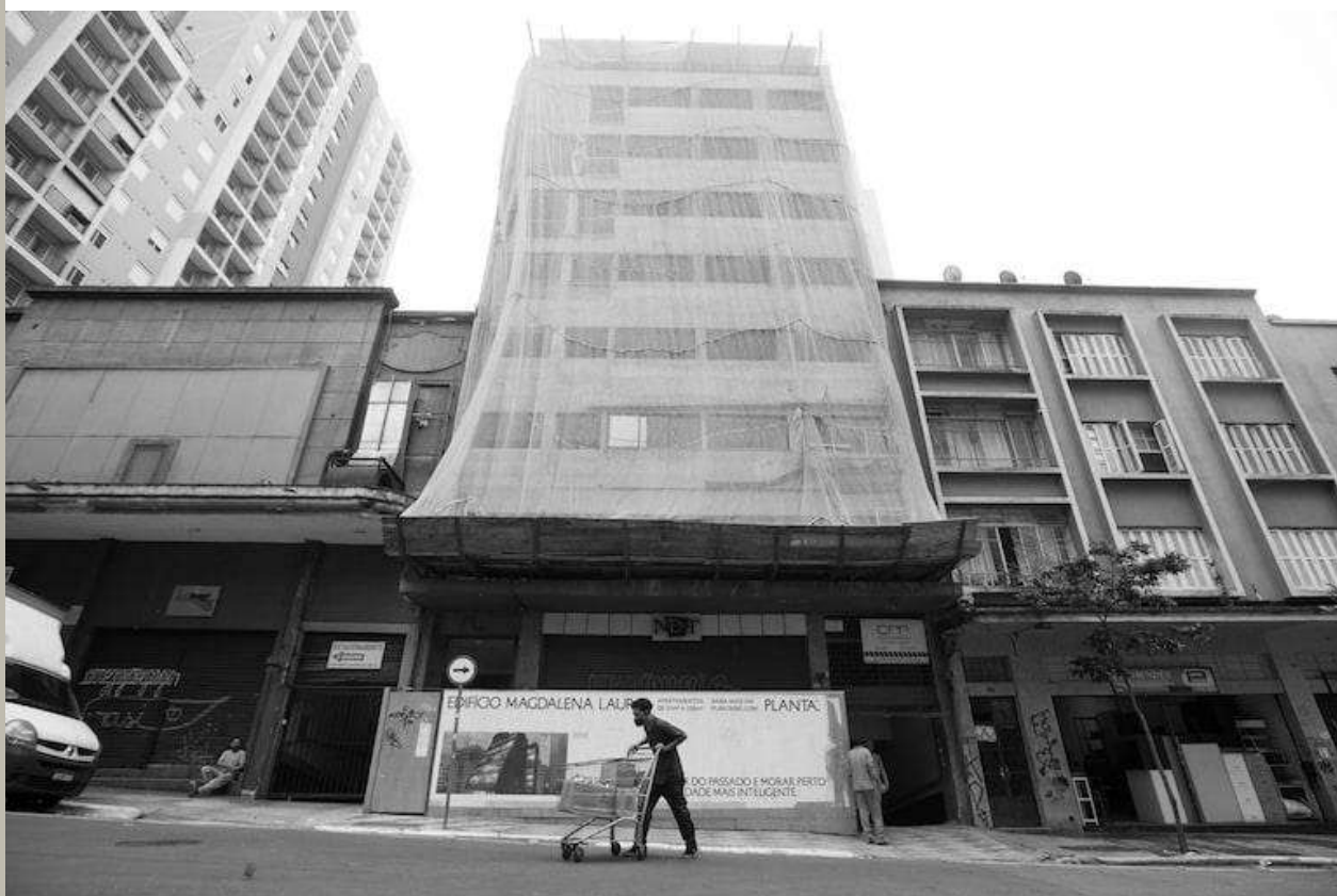
Figura 20: Fachada durante a obra de renovação do edifício. Fonte: Estadão, 2021.
