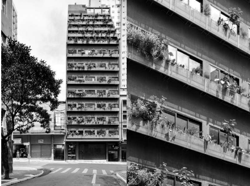
Figura 21 e 22: Fachadas após a intervenção. Fonte: ArchDaily, 2022.
