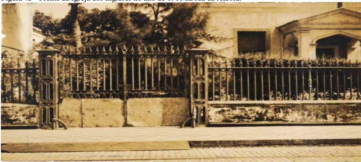
Figura 45 - Frente da Igreja dos Ingleses no ano de 1910 na rua da Aurora.
