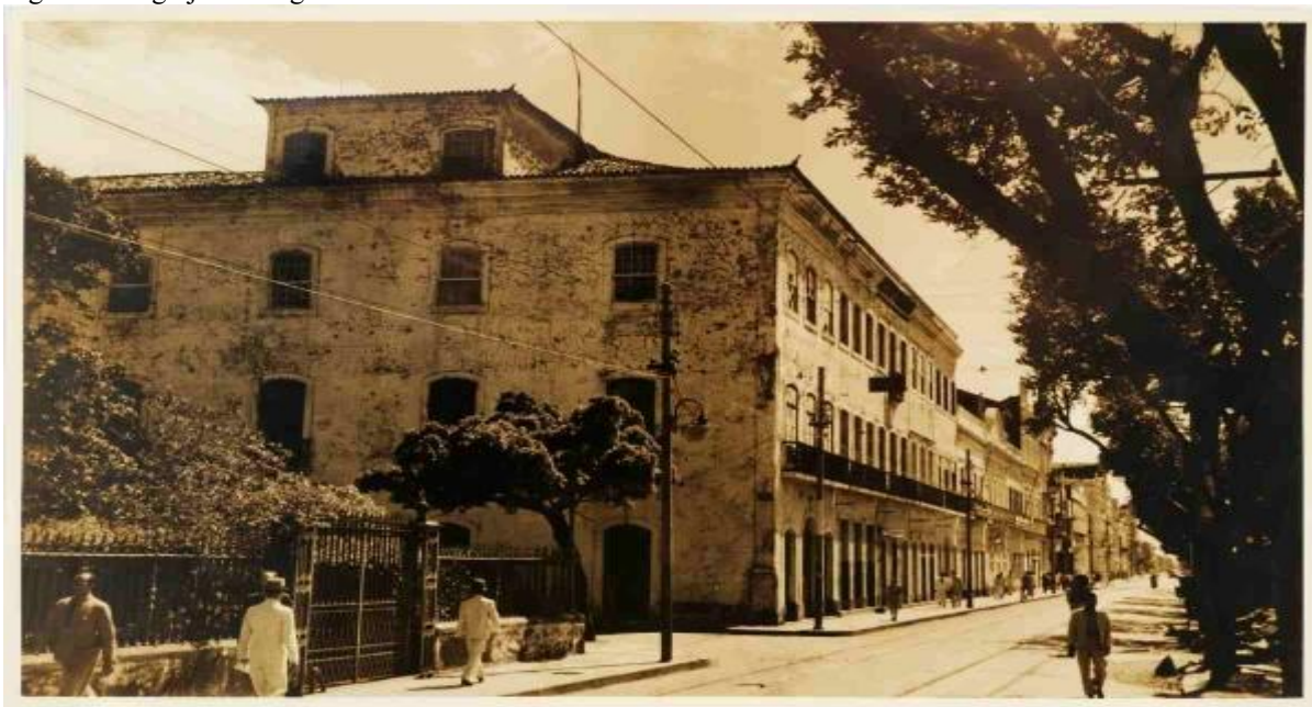
Figura 44 - Igreja dos Ingleses no ano de 1943 na rua da Aurora.
