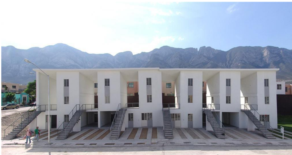
Figura 16– Visão de uma das fachadas da Habitação Monterrey.Habitação Monterrey -Elemental .Fonte: Archdaily, 2012. Disponível em : https://shre.ink/x1WC . Acesso em: 07 Maio, 2025.
