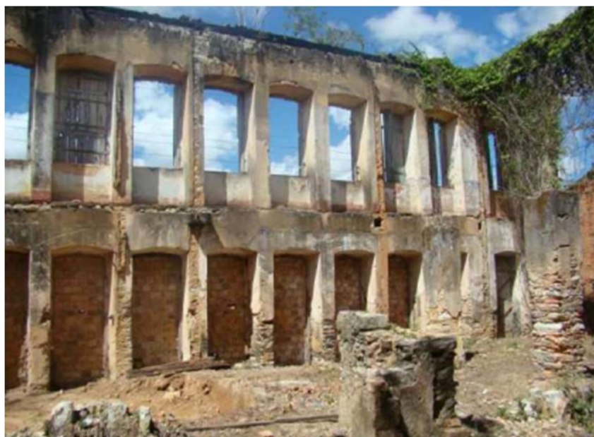
Figura 88 – Vazio interno do Sobrado 159 em 2008. Destaque para o fato de que o pavimento superior proposto foi recuperado a partir do resgate da antiga tipologia. Fonte: Castro, 2008, in Costa, 2013.
