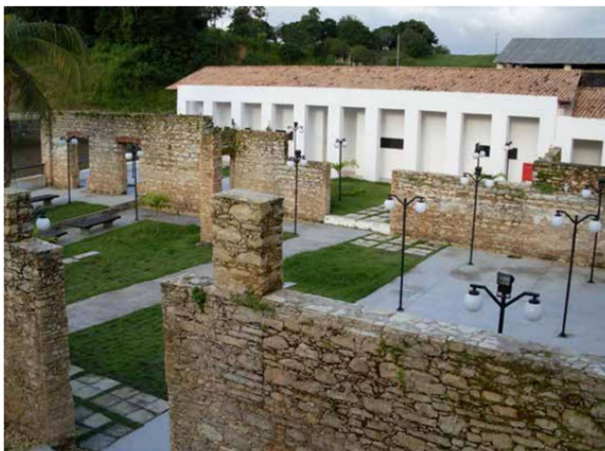
Figura 92 – O remodelamento interno das Ruínas em frente ao Mercado e das Ruínas ao lado do Sobrado 159 com a solução de pórticos incorporada do anteprojeto. Fonte: Rodrigo Baeta, 2008, in Nery e Baeta, 2022.
