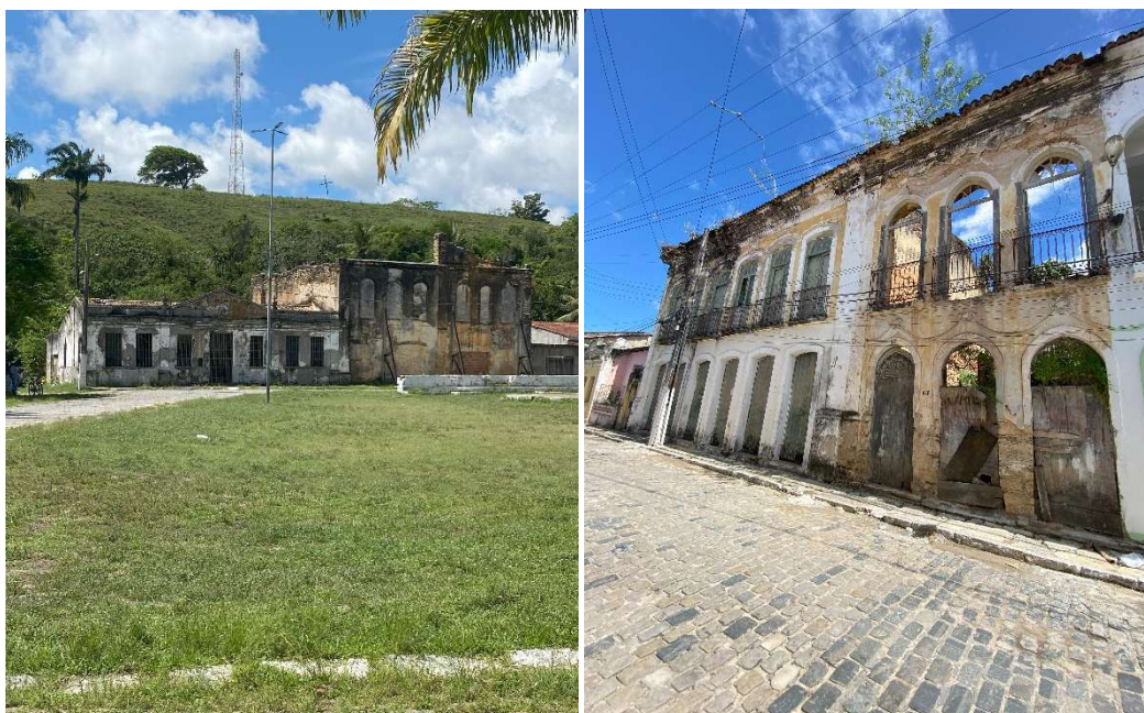
Figuras 43 e 44 - À esquerda, ruínas da antiga cadeia e do antigo Teatro São Pedro. À direita, ruína no centro da cidade entre edificações com diferentes graus de conservação. Fonte: a autora, 2024.
