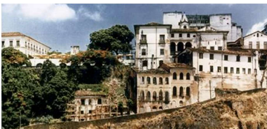
Figura 16: Vista da Ladeira da Misericórdia, Salvador/BA no estado pré-intervenção.
