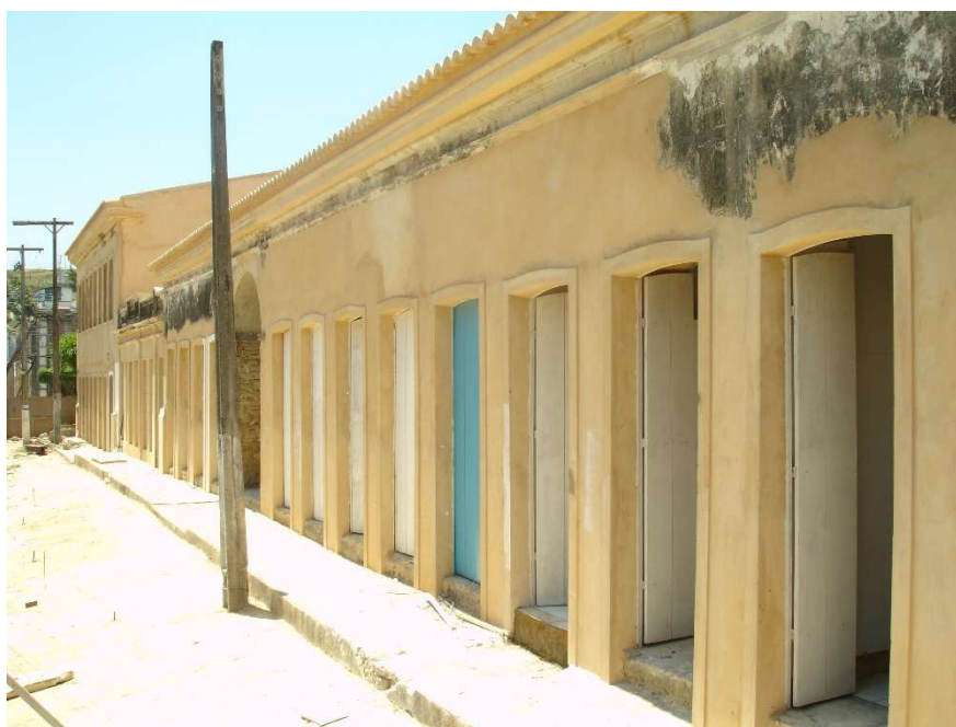
Figura 134 – Recuperação da fachada Leste do Quarteirão dos Trapiches voltada ao Mercado durante as obras em 2008. Fonte: Marcelo Maciel.
