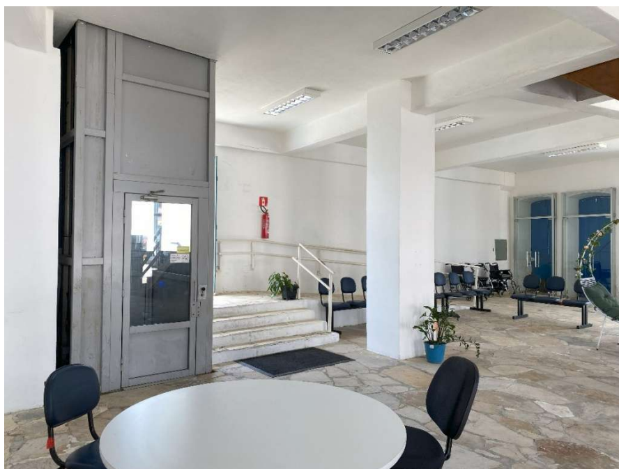
Figura 79 – Hall de acesso ao “Quartirão dos Trapiches” no pavimento térreo do Sobrado 159. Detalhe para a plataforma elevatória, a estrutura de concreto armado e o piso em pedras calcárias. Fonte: a autora, 2025.
