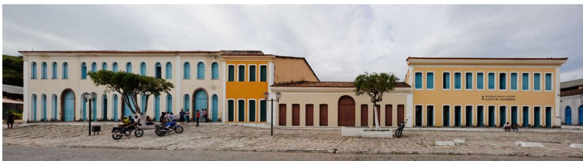
Figura 4 – Campus da Universidade Federal de Sergipe no Quarteirão dos Trapiches na década de 2010, Laranjeiras/SE. Fonte: acervo IPHAN/SE in Gianecchini, 2022.
