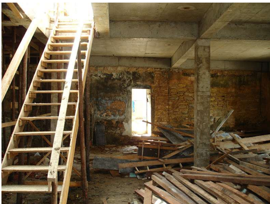
Figura 82 – Exposição da nova estrutura inserida no Sobrado 159 no momento de execução das obras (2008). Fonte: Marcelo Maciel.
