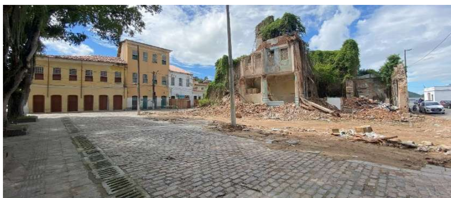
Figura 263 – Praça Góes Calmom e arredores, às margens do rio Paraguaçu, na área do antigo Porto de Cachoeira. Detalhe para o conjunto edificado remanescente e para as ruínas do antigo Hotel Colombo. Fonte: A autora, 2024.
