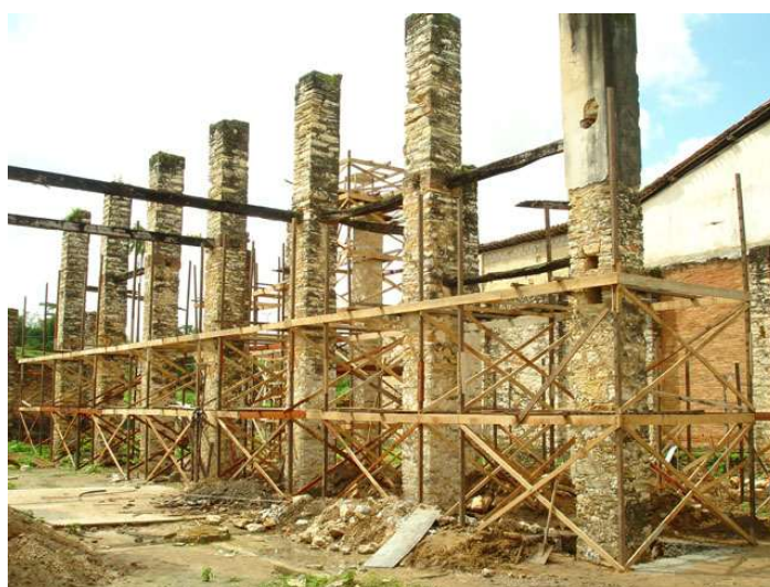
Figuras 106 e 107 – Pilares de pedra a serem consolidados e preservados na Praça dos Pilares. À esquerda, no momento pré-intervenção em 2003. À direita, já no momento de execução das obras em 2008. Fonte: Rodrigo Baeta in Nery e Baeta, 2022 (à esquerda); Marcelo Maciel (à direita).
