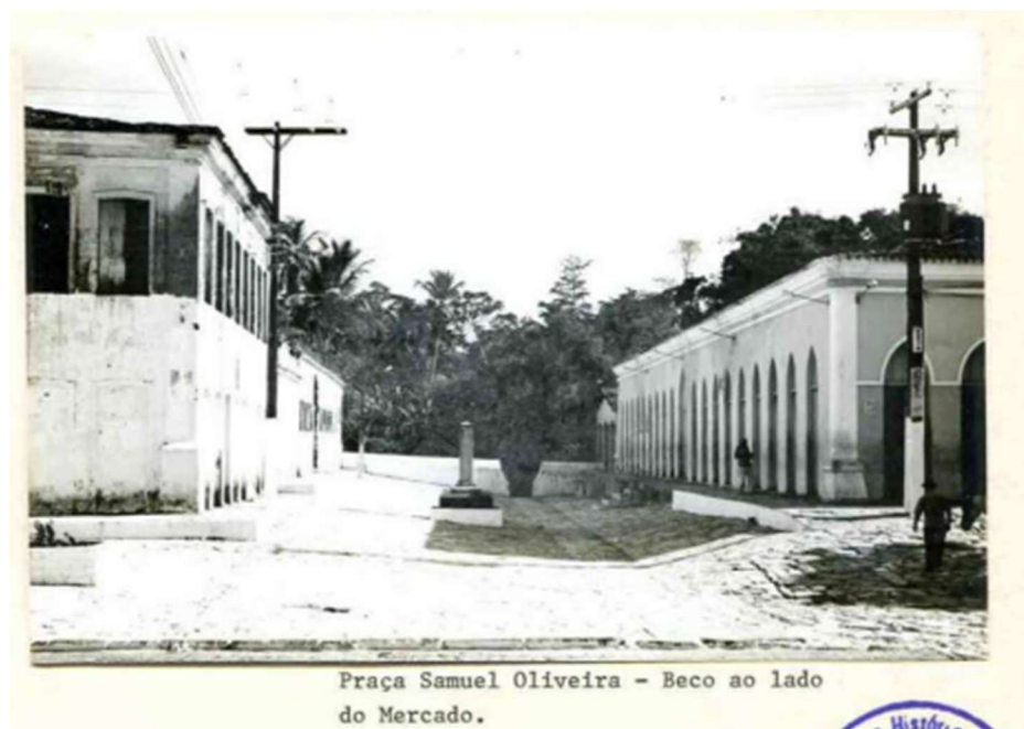
Figura 57 – Beco entre o Mercado e o Quarteirão dos Trapiches na década de 1990. No canto esquerdo, parte do Sobrado 159, visualmente já em estado de degradação avançado naquele momento. Fonte: IPHAN, 1996.
