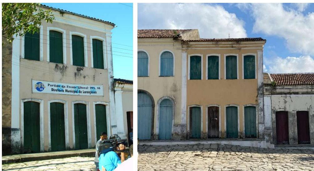
Figuras 141 e 142: À esquerda, fachada principal do Sobrado 117 em 2008, antes da intervenção. À direita, a mesma fachada em 2025, pós intervenção. Fonte: Marcelo Maciel (à esquerda); a autora (à direita).
