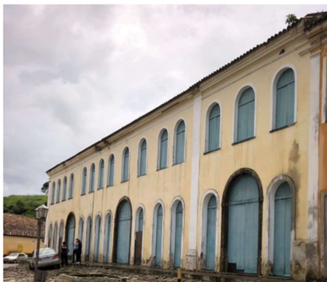
Figuras 126 e 127 – Fachada principal do Trapiche Santo Antônio em 2012 (acima) e em 2022 (abaixo), já reconstituída após as intervenções. Fonte: Rodrigo Baeta in Nery e Baeta, 2022; a autora, 2022.
