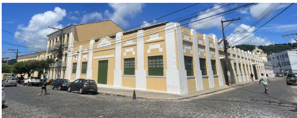
Figura 214 – Fachadas voltadas à R. Eng. Lauro de Freitas e R. Monsenhor Tapiranga pós-intervenção. Fonte: a autora, 2024.
