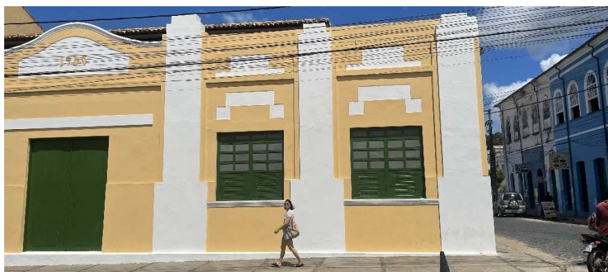
Figuras 215 a 217 – Destaque para a forma e escala das aberturas voltadas ao antigo uso fabril, com esquadrias reconstituídas. Fonte: a autora, 2024.
