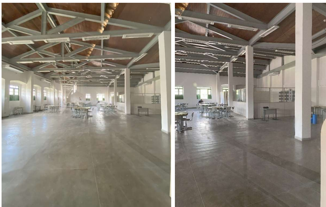
Figuras 249 e 250 – Biblioteca do campus da URFB no 1º pav. Detalhe para o amplo vão alcançado por meio da intervenção. Fonte: a autora, 2024.
