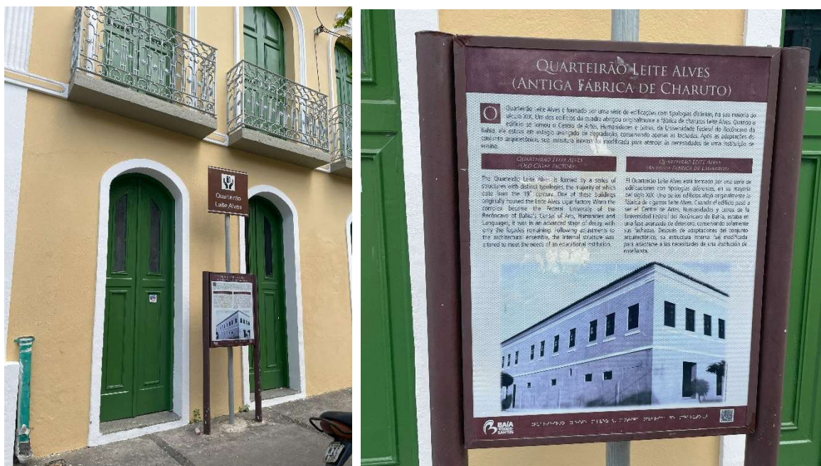
Figura 212 – Placa com identificação do “quarteirão”, assim como do estado de degradação avançado em que ele se encontrava e da adaptação da sua estrutura interna. Fonte: a autora, 2024.
