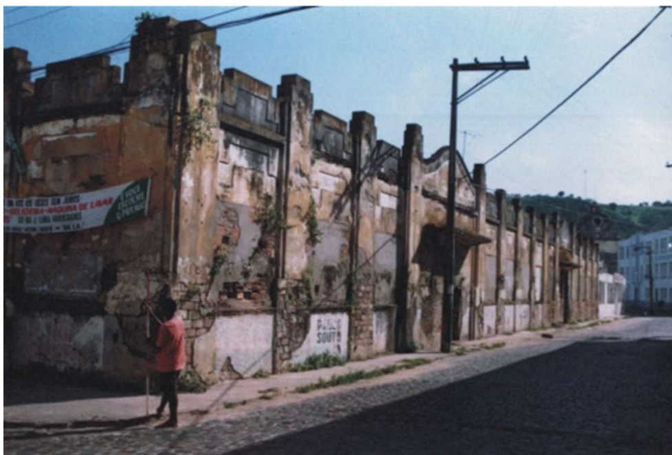
Figura 194 – Vista da fachada voltada à R. Monsenhor Tapiranga no início dos anos 2000. Detalhe para a presença de características art decó ainda perceptíveis. Fonte: Escritório de Projetos do Programa Monumenta de Cachoeira, 2010.
