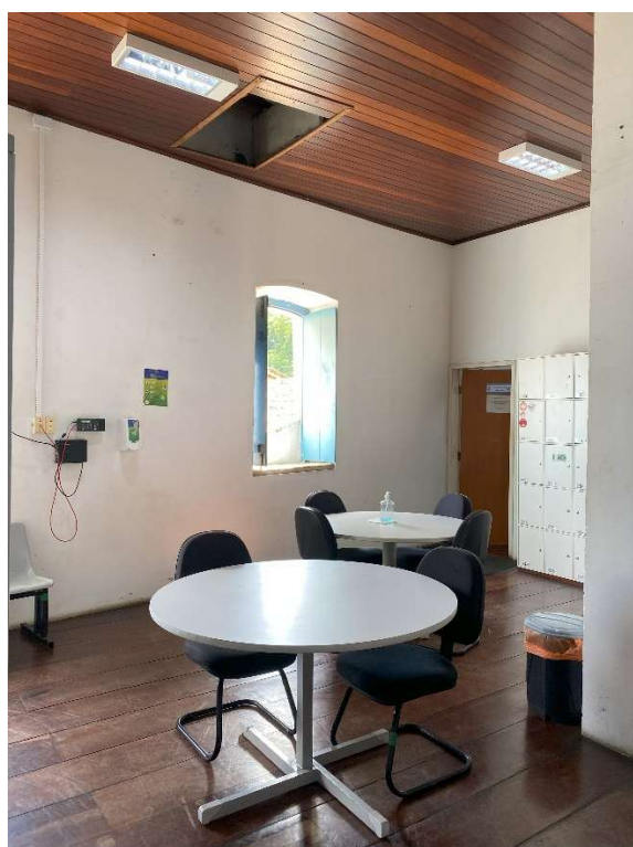
Figuras 86 e 87 – Pavimento superior do Sobrado 159 em 2025. Detalhe para o piso e o forro em madeira. No entanto, indica-se o possível falso histórico gerado a partir da ausência de clareza acerca da indicação das ações contemporâneas na recuperação do pavimento. Fonte: a autora 2025.
