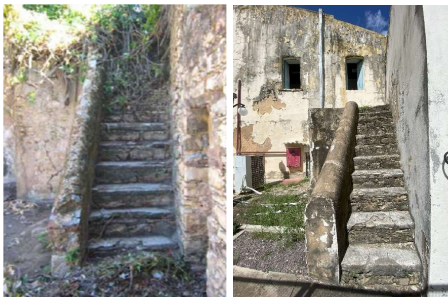
Figuras 97 e 98 – À esquerda, estado da escada no momento pré-intervenção em 2008. À direita, a escada hoje. Fonte: Castro, 2008, in Costa, 2013 (à esquerda); a autora, 2025 (à direita).
