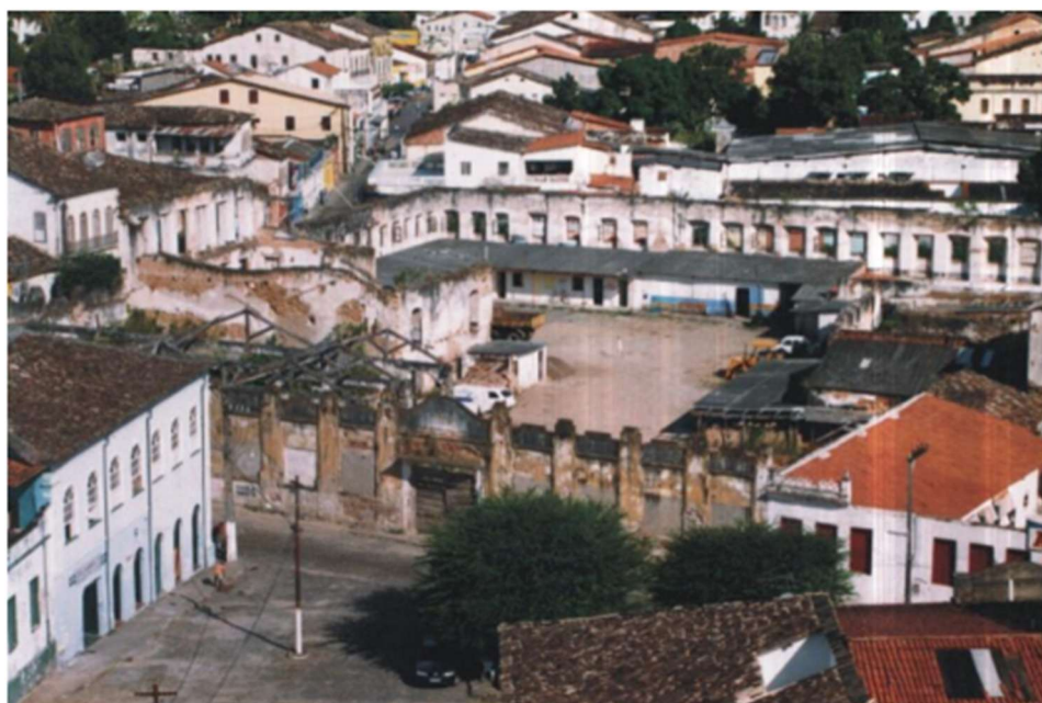
Figura 191 – Vista das fachadas do “quarteirão” em ruínas. Detalhe para o vazio interno no início dos anos 2000. Fonte: Escritório de Projetos do Programa Monumenta de Cachoeira, 2010.
