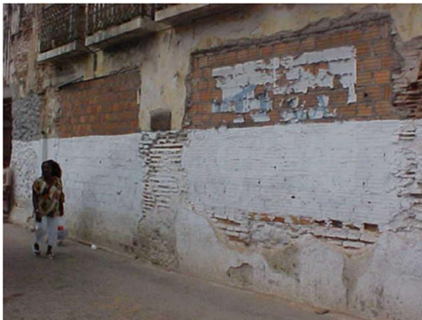
Figura 196 – Vedação das aberturas em uma das fachadas do quarteirão com tijolo maciço e bloco cerâmico de seis furos no início dos anos 2000. Fonte: Escritório de Projetos do Programa Monumenta de Cachoeira, 2010.
