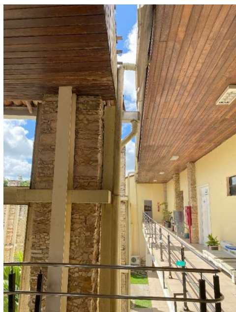
Figuras 119, 120 e 121 – Detalhe da integração entre os dois edifícios a partir da escada e para o “toque” das suas coberturas por meio das instalações de drenagem pluvial. Fonte: a autora (2025).
