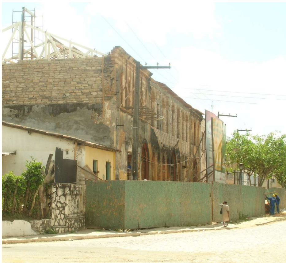
Figura 125 – Reconstituição de parte da fachada do Trapiche Santo Antônio em 2008. Externamente, não é possível identificar a parte reconstituída. Fonte: Marcelo Maciel.
