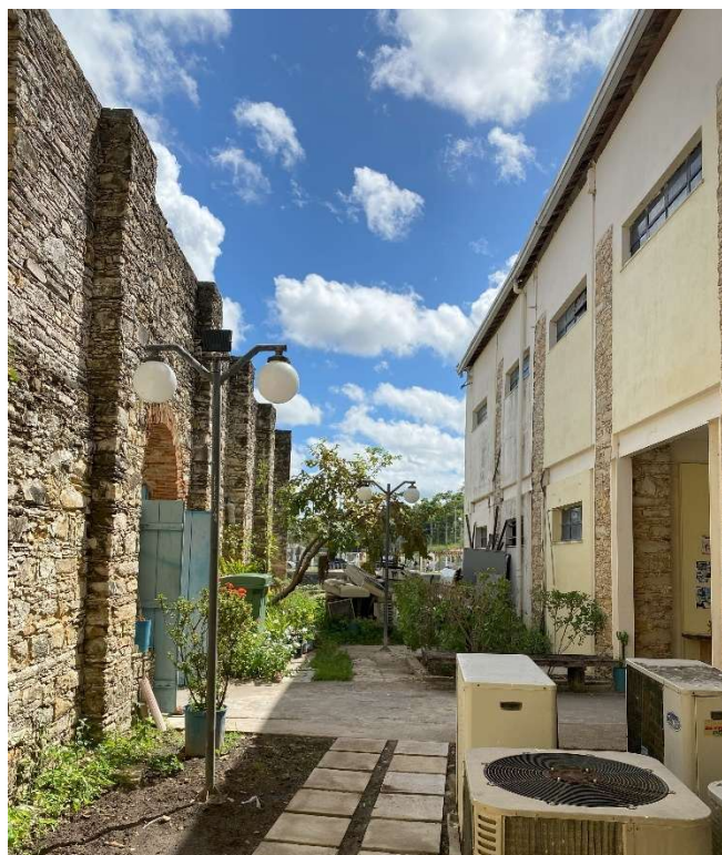
Figura 116 – À esquerda, o muro de pedra remanescente consolidado que limita o “quarteirão”. À direita, a incorporação dos antigos pilares ao novo edifício. Fonte: a autora, 2025.
