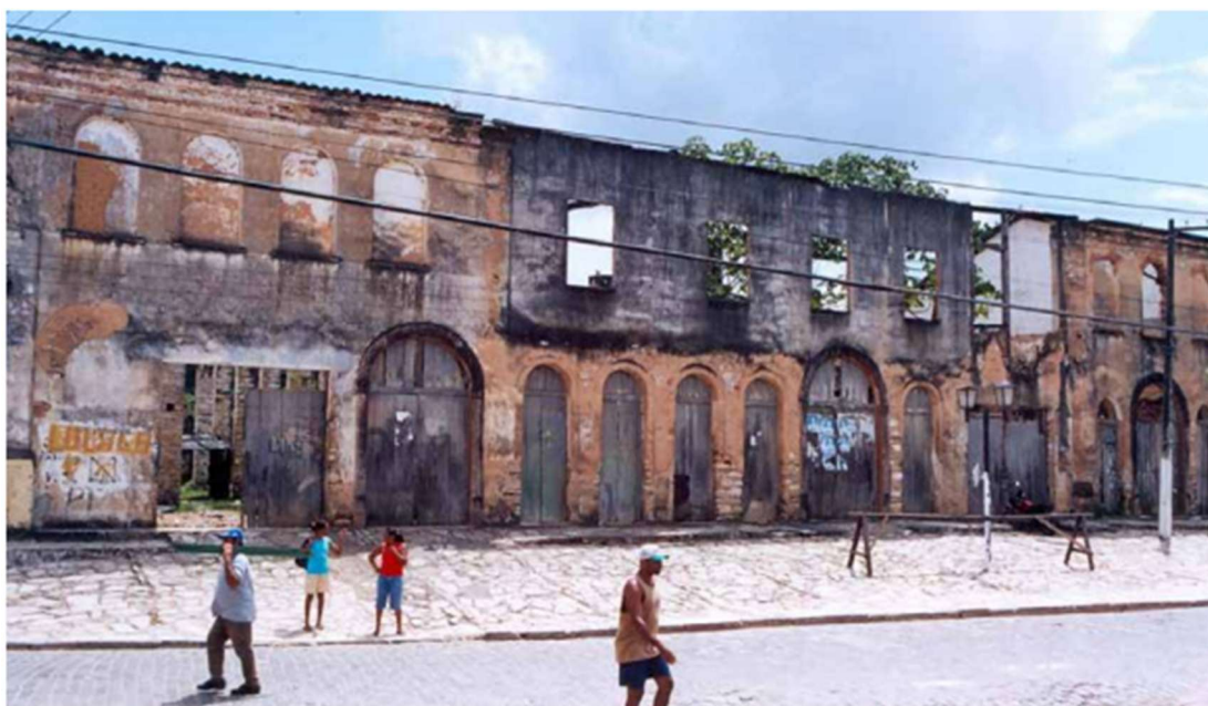
Figura 59 - Fachada arruinada do Trapiche Santo Antônio com destaque para o acréscimo recente de tijolos em parte da sua fachada principal em 2003. Fonte: Rodrigo Baeta in Nery e Baeta (2022).
