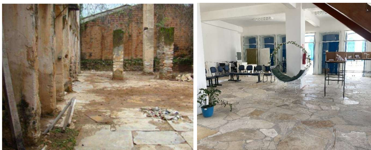
Figuras 83 e 84 – À esquerda, piso em pedras calcárias no Sobrado 159 revelado após as sondagens arqueológicas no momento pré-intervenção. À direita, o piso “recuperado” numa organização diferente da original. Fonte: Castro, 2008 in Costa, 2013 (à esquerda); a autora, 2025 (à direita).
