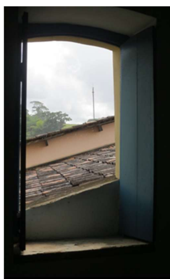
Figuras 94 e 95: A nova cobertura cortando a antiga janela do Sobrado 159.
