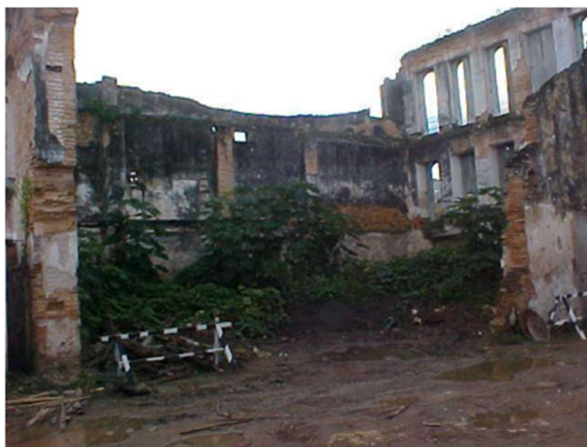
Figura 195 – Vista interna do “quarteirão” no início dos anos 2000. Detalhe para a fragmentação característica das ruínas, com poucos remanescentes da alvenaria interna e preservação da caixa mural. Fonte: Escritório de Projetos do Programa Monumenta de Cachoeira, 2010.
