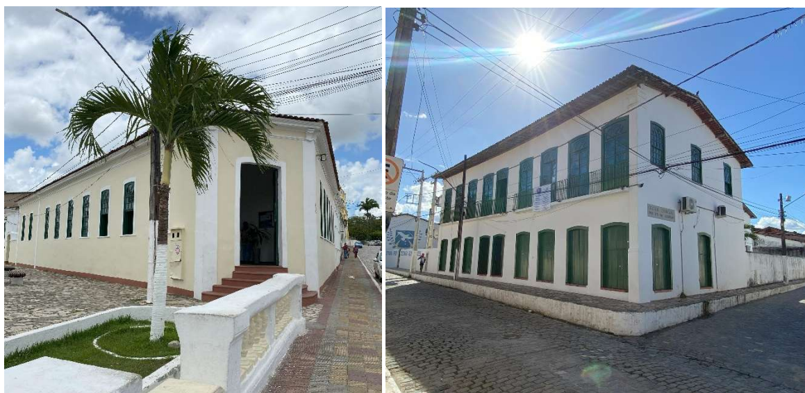
Figuras 37 e 38 - À esquerda, edifício do Paço Municipal. À direita, sobrado que abriga o atual colégio estadual Prof. a . Zizinha Guimarães. Fonte: a autora, 2024.
