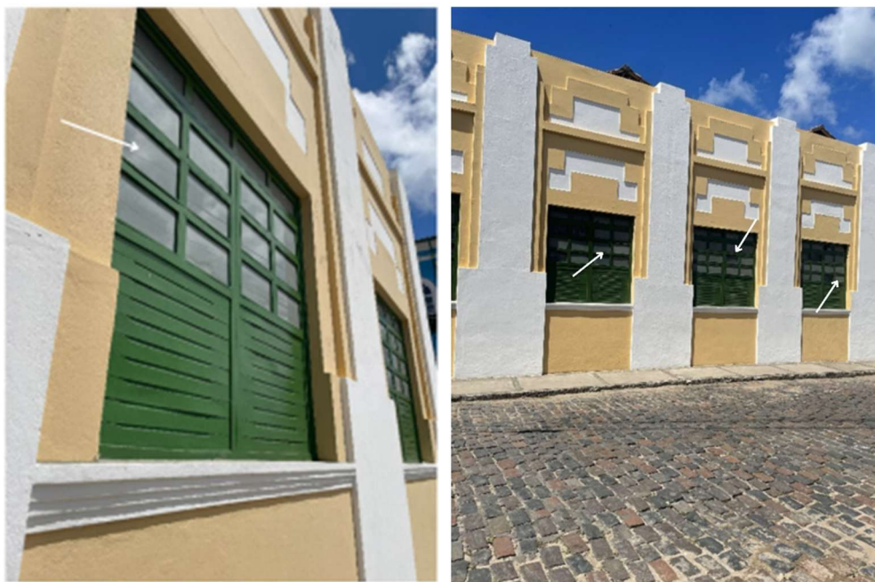
Figuras 220 e 221 – Detalhe para o fechamento interno das esquadrias reconstituídas na fachada voltada à R. Monsenhor Tapiranga. Fonte: a autora, 2024.
