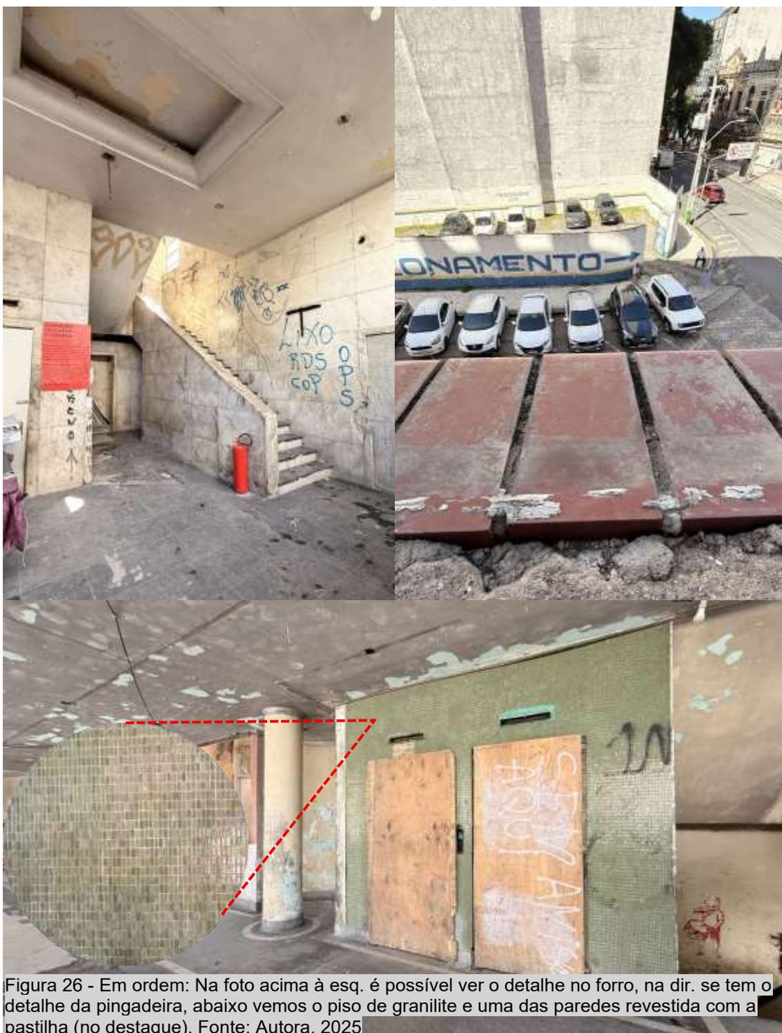
Figura 26 - Em ordem: Na foto acima à esq. é possível ver o detalhe no forro, na dir. se tem o detalhe da pingadeira, abaixo vemos o piso de granilite e uma das paredes revestida com a pastilha (no destaque). Fonte: Autora, 2025
