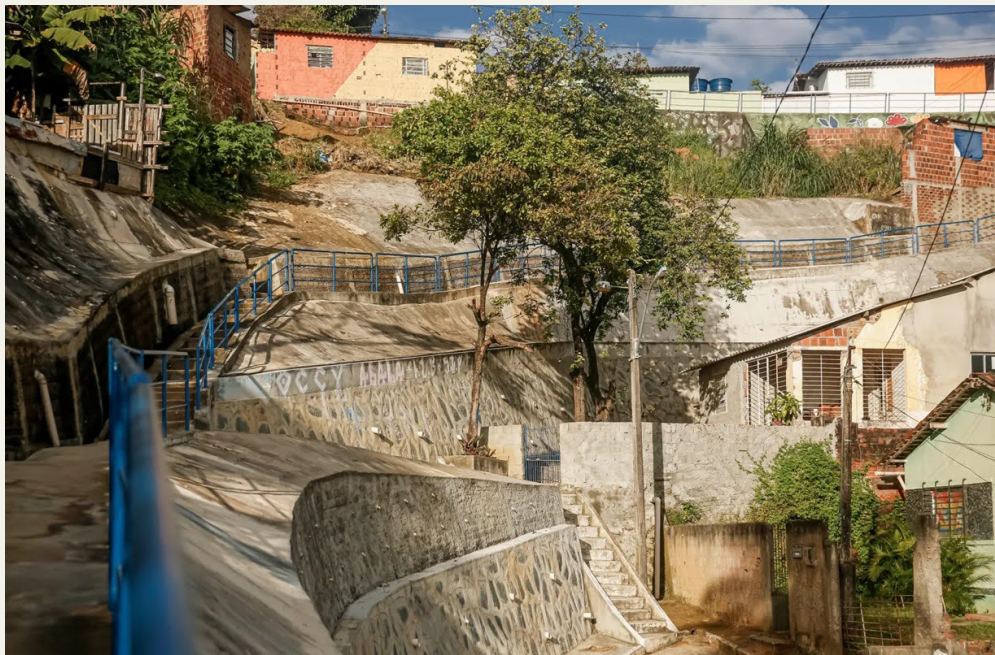
Figura 16 - Muro de arrimo no recorte de intervenção projetual
