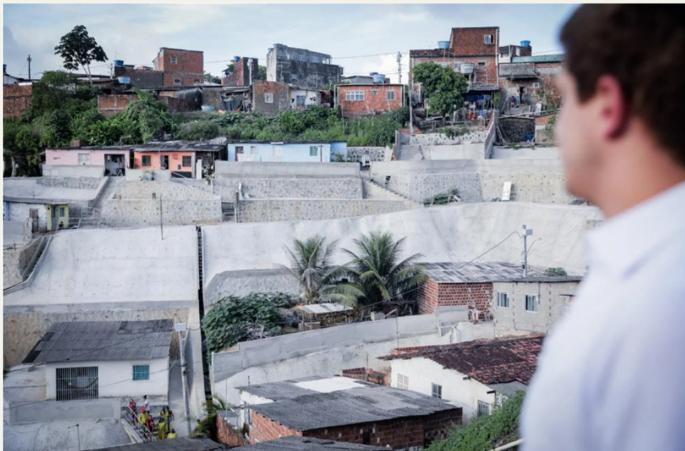
Figura 13 - Contenção de encostas no Recife Fonte: Prefeitura do Recife, 2024.
