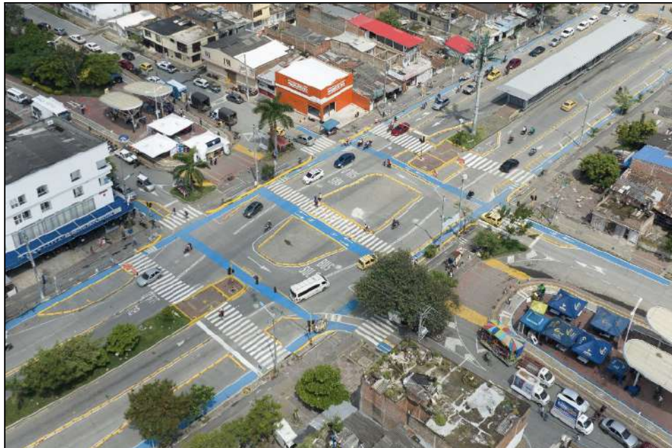
Figura 26: Cruzamento complexo com infraestrutura cicloviária em Cali, Colômbia
