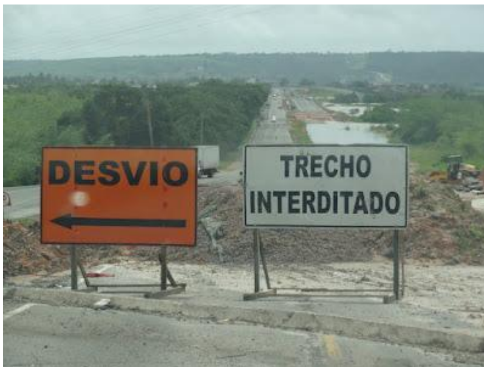
Figura 26. Registro da inundação em Goiana (2011). Rodovia federal BR-101 em reforma.
