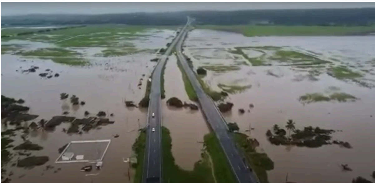
Figura 19. Registro aéreo da inundação em Goiana (2022): monocultura da cana-de-açúcar , estação elevatória e BR-101 afetadas pelo transbordamento do canal do Baldo do Rio e Rio Capibaribe-Mirim.
