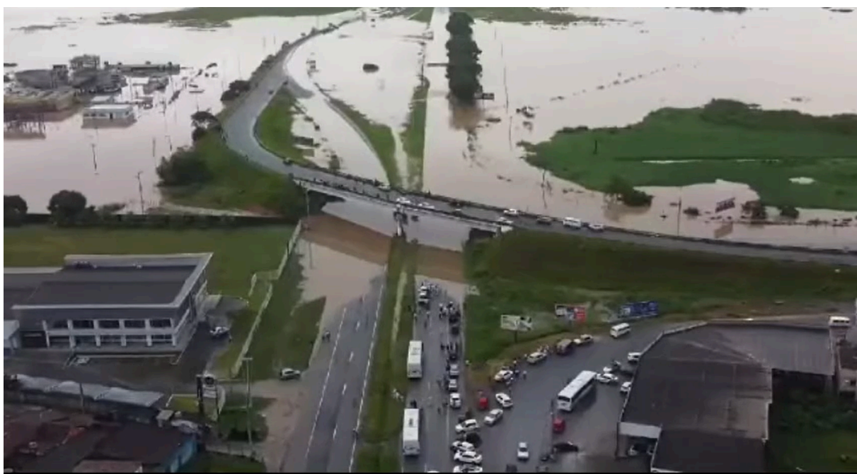
Figura 18. Fotografia aérea da inundação de 2022 no município de Goiana. BR 101 e Estação de Tratamento de Esgoto submergida pelo rio Tracunhaém.
